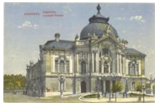
20426. Budapest XIII. Vig színház (kis szakadás) T3800
