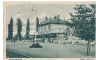
20120. * Balatonföldvár, va sútállomás (fa) T3 1200
