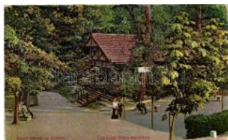
21119. * Félixfürdő, vasútállomás / railway sta T2/35000
