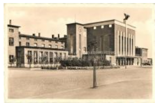
21959. ☒ Olomouc, Olmütz; Hauptbahnhof / Rail T2 1000
