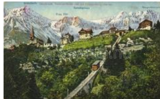
21774. ☒ Innsbruck, Drahtseilbahn auf die Hun T2/31000
