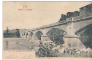
22538. * Alba, Ponte sul Panaro / bridge (f) T2 1000
