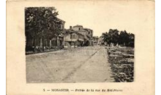
22332. * Monastir, Bitola; E ntrée de la rue du Ro T21600
