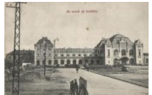
21044. ✱ Arad, Új indóház, vasútállomás, kiad T2/ 32000
