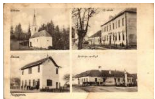
20742. ✱ Nagygyéncs, Gencsapáti; Vasútállomás T34400
