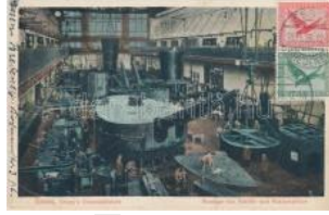
22434. ☒ Essen, Krupp's Gusstahlfabrik / asse T2/31400
