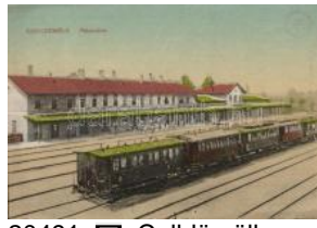
20491. ☒ Celdömök, vasút állomás (EK) T2/3 4000
