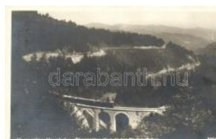
21799. ** Mariazeller Alpenbahn, Sturzgraben via T800 60
