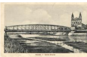
22269. ☒ Vilnius, Wilna; Grüne Brücke / bridge T2 3000
