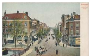
22138. ** Rotterdam, Jonkerfransstraat / street T2 1000
