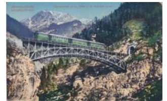
21816. ** Schlosbachbrücke der Mittenwaldb T2/31000
