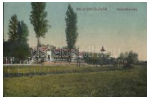
20119. ☒ Balatonföldvár, va sútállomás (fa) T3 1800
