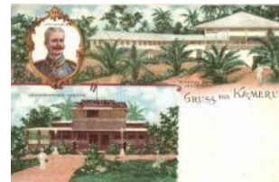
22175. ** Kamerun, Government Buildings-Gebäude T2/3 4000
