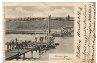
23233. ☑ Schlagen einer halbermanenten Brücke T4800
