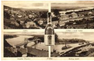
21241. ☒ Tokaj, Vasúti híd, Erzsébet Tisza híd, e T4000
