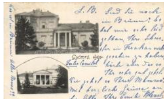
20689. ☒ Gyömrő kastély (ázott / wet damage) T4 1800
