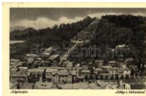
21053. ☒ Salgótarján, kálvá ria (EK) T2/3 1000
