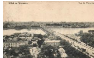
22219. ☒ Warsaw, Warszawa; (wet damage) T3 800
