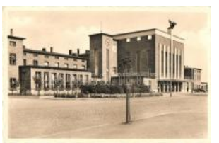
22028. ☒ Olomouc, Olmütz ; Hauptbahnhof / Rail T2 1000
