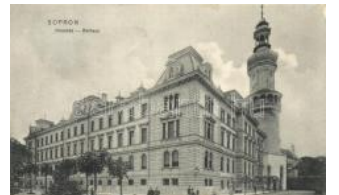
21087. ☒ Sopron, Városháza (EB) T3 1200
