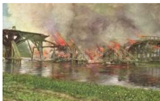
23053. * Hidrobbantás / Brückensprengung au T1/21400
