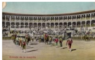
23662. ** Entrada de la c uadrilla / gang entry T2/31400
