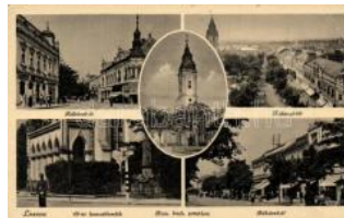
21546. ☒ Losonc, Rákóczi út, Római katolikus te T2/3 800
