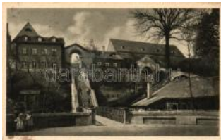
22917. ☒ Augsburg, Schwedenstiege / swedish T2/31400
