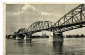
22060. * Komárom, Nagyduna-híd, volt trianon T2/3/400
