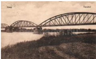
22241. * Csep, Tiszahíd / bridge (wet damage) T3 1400
