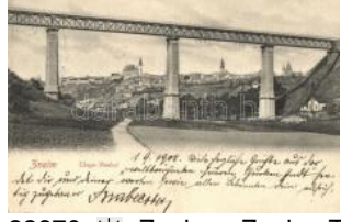
22670. ✱ Znojmo, Znaim; Taha viaduct (Rb) T 2/3 2000
