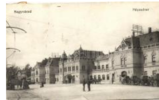
21852. ✱ Nagyvárad, Vasútállomás / railway sta T21400
