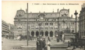
22710. ** Paris, Gare Saint Lazare et Entrée d T21000
