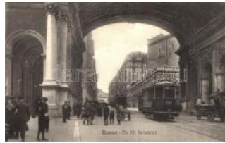
23066. ** Genova, Via XX Settembre / street, T2/32000
