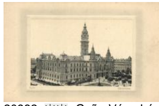
20982. ✱✱ Győr, Városháza, Hermann Izidor kora T2/1400
