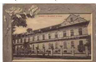
21171. ✳ Makó, Erzsébet árvaház (kis szakadás) T33000
