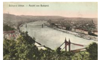
20272. ✱ Budapest, No. 1. (ázott / wet damage) T3 1000
