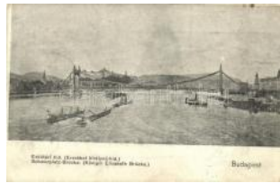
20310. ☒ Budapest, (Esküteri híd) Erzsébet híd (E T3000)
