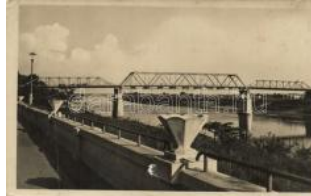
21542. ☒ Szolnok, Tisza-híd (fa) T3 1000
