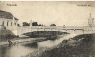
21923. ☒ Temesvár, Malomtéri híd / bridge (EK) T2/3600
