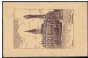
22422. ☒ Újvidék, Városháza / town hall s: Lamos T2000
