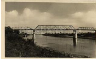
21541. ☒ Szolnok, Tisza-híd T2 1000
