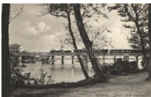
23013. * Chiavari, Entella, Ponte ferroviaria / r T2/31000
