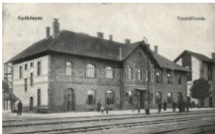
20961. ☒ Gyékényes, vasútállomás (kis szakadá T3000
