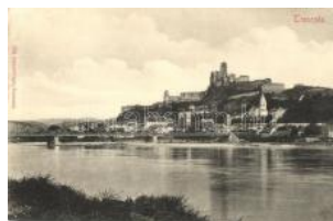
22215. ✱✱ Trencsén, híd, vár / bridge, castle (áz) T3 1800
