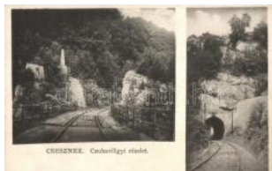
20793. ✳✳ Csesznek, Cuhavölgyi vasúti alagút T2/31200
