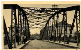
22254. ** Munkács, Híd / bridge T1/2 1200
