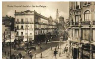
23226. ** Porto, Praca da Liberdade e Rua dos T11600
