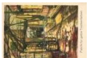
24074. * Gebr. Hartmann, Halle-Ammendorf, D T2/3000
