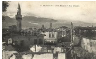
22858. * Bitola, Monastir; Petit Minaret et Rue d'O T2800
