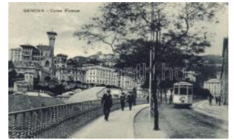
22876. ☒ Genova, Corso Firenze, tram 275 T2 1400
