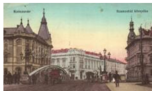
21375. ☒ Kolozsvár, Szamosfalva híd környéke / bri T2/31400
