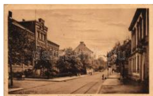
22731. * Castrop, Amtsgerecht u. Wittenerstrasse T4 1000
