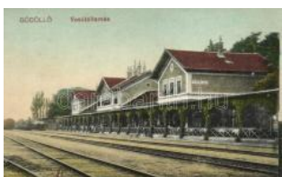
20614. ✱ Gödöllő, Vasútállomás (EK) T2/3 2000
