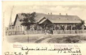
20590. ☒ Felsőgalla, Kőszénbánya, bányairoda, T2 4000
