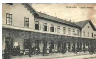
20782. ☒ Kiskőrös, Vasútállomás (fl) T2/3 2600
