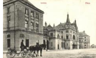
20968. ☒ Pécs, Indóház, vasútállomás (fa) T3 1400
