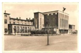
22346. ☒ Olomouc, Olmütz; Hauptbahnhof / Rail T21000
