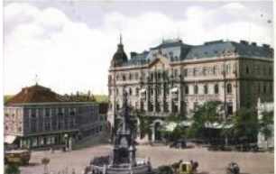
20973. ✱ Pécs, Takarékpénztár, villamos, autom T2/3000
