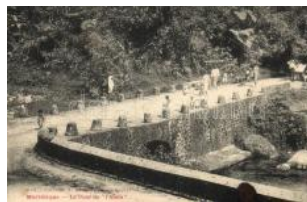
22635. ** Le pont de 'Alm a' / bridge (fl) T2/3 1000
