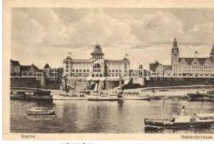
22529. ✱✱ Szczecin, Stettin; Hakenterrasse / T2/31400
