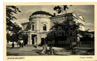
21501. ☒ Szatmárnémeti, színház / theatre T2/3 1400
