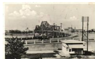
21933. * Újvidék, Pétervárad híd / bridge T2 900
