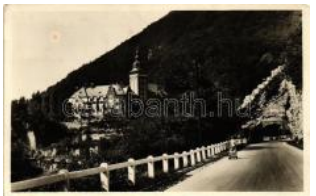
20918. ☒ Lillafüred, Palota szálló alagúttal T2 1200
