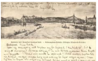
20314. ☒ Budapest, (Esküteri híd) Erzsébet híd T2/31800
