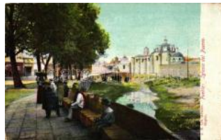
22624. ✱✱ Puebla, Iglesia del Puente / church T2/3 1000
