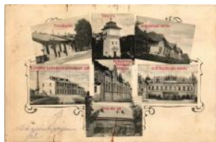
21631. ☒ Királyhelmec, vasútállomás, víztorony, T23000
