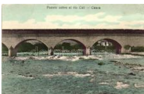
22491. * Cauca, Puente sobre el rio Cali / river T2/31000
