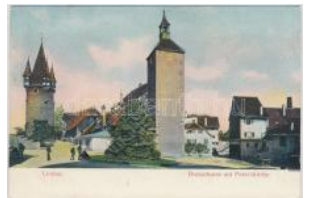
22713. ** Lindau, Diebsturm, Peterskirche / to T 1600
