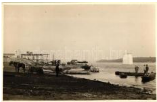
20638. ** Dunaföldvár, híd építés, photo T1/2 4600
