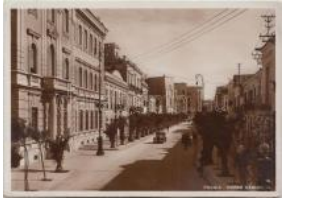
22795. ☒ Foggia, Corso Garibaldi T2 1200
