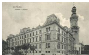
21167. ☒ Sopron, Városháza (EB) T3 1200
