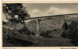
21847. ☒ Volóc, Kisszolyva i viadukt T2 1200
