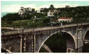
22947. ** Madeira, viaduc t T2 1000
