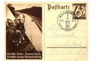
23906. ☒ 1933 Erster Spatenstich - 1936 1000 km T3800
