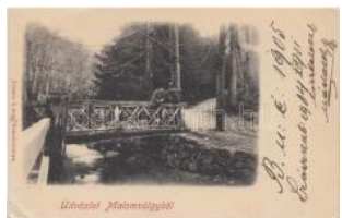
21960. ☒ Szászkabánya, Malomvölgy, híd / valle T32200
