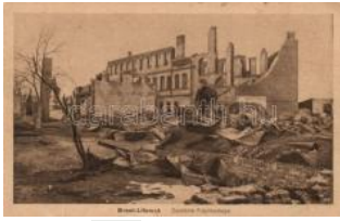
22551. ** Brest-Litovsk, Zerstörte Fabrikanlage T41400
