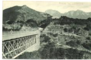
22557. ** Jablanica, Brücke / bridge T1 800
