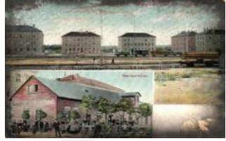
22936. ** Nürnberg, Rangierbahnhof, Restoration T2/32000
