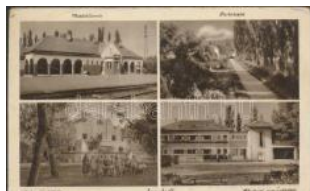
21744. ☒ Zamárdi, Vasútállomás, park, Dolgoz T2/31000
