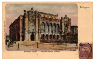
20564. ✱ Budapest V. Viga-dó T2 1200
