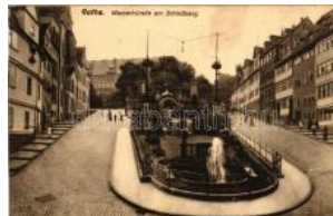
22865. ** Gotha, Wassertürme am Schloss T2/31000
