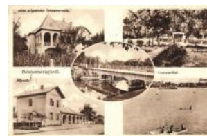
20258. ☒ Balatonmáriafürdő, Csatorna-híd, vas T2/31600
