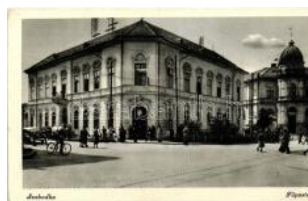
22368. ☒ Szabadka, Főposta / post office, autom T31400
