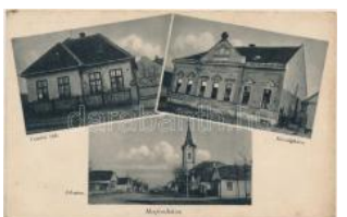
21155. ✱ Majosháza, Tanító lakás, községháza, T2/31000
