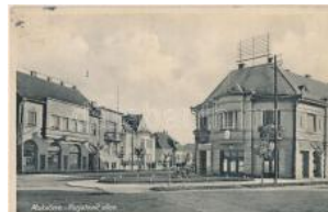
22269. ✱ Munkács, Korjatóvic utca / street (EK T2/31200
