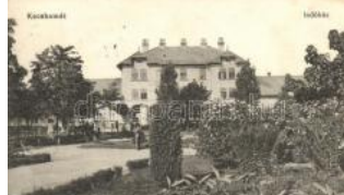
21081. ☒ Kecskemét, Indóház, vasútállomás (EB) T31000
