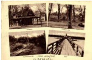
21260. ☒ Nyíregyháza, vasútállomás, híd, villa T2/3 1400
