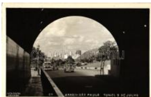
22579. ☒ 1952 Sao Paulo, Tunel 9 de Julho, aut T21000
