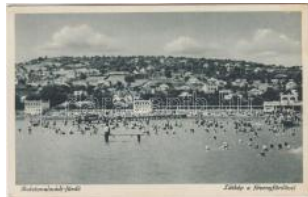
20192. * Balatonalmádi-fürdő, fővenyűrdő (Rb) T3 800
