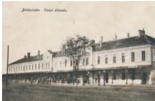
20160. ** Békéscsaba, Vasútállomás (EB) T2/3 1400
