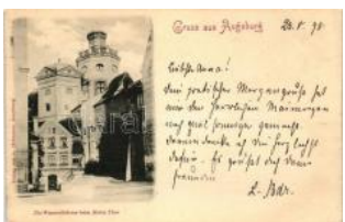
22035. ☒ 1898 Augsburg, Die Wasserthürme beim T4 400
