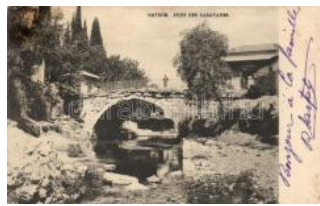
22516. * Smyrna, Pont des Caravanes / bridge T2 1200
