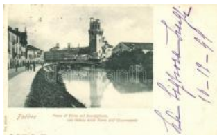
22201. ☒ Padova, Ponte di Ferro sul Bacchiglio T2/31400
