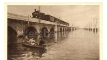
22350. ✱✱ Venice, Venezia ; Ponte della Ferrovia T2000
