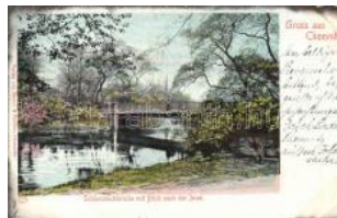
22057. ☒ Chemnitz bridge (EK) T3 1000
