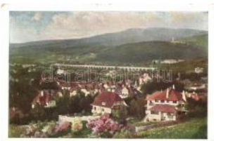
21383. ✱✱ Baden bei Wien, Aquadukt / Aqed T2/3 1200
