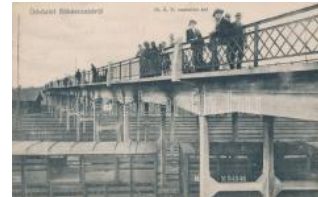
20162. ☒ Békéscsaba, MÁV Vasbeton híd, vonat T 3000
