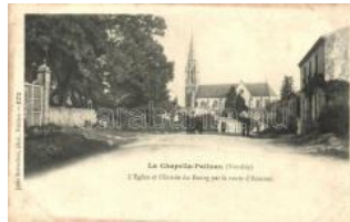
21661. ** La Chapelle-Palluau, Eglise, Entrée T2/3400
