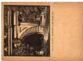
20217. ✱✱ Budapest I. Ala gút, építette Clark Ad T31600
