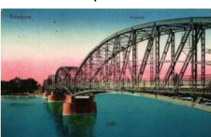
20937. ☒ Komárom, Duna híd / bridge T2 1000
