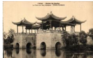
21890. ☒ Yangtze, Pont aux cinq kiosques / bridge T2/1200
