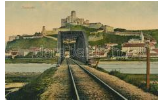
21090. * Trencsén, vasúti sín és híd, vár / railway T21400
