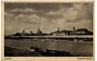
21555. ✳ Szolnok, Tisza part (ázott / wet damage) T400
