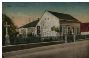
22340. ** Csap, Plébánia lak / rectory (b) T4 1400
