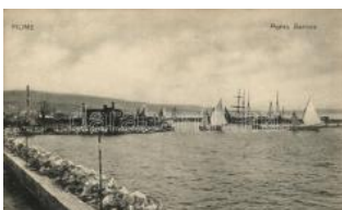
22435. ☒ Fiume, Porto Barossa / port T2 1600
