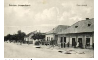
22066. ✱ Dunamócs, utca, üzlet / street, shop T2/3 4000
