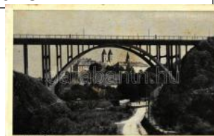
21642. * Veszprém, viaduk t (fa) T3 1000
