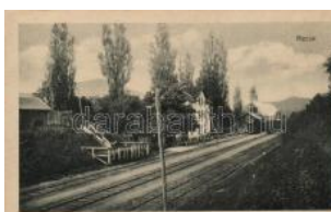
21368. ** Recsk, vasútállomás (EK) T2/3 2600
