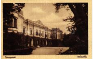
21387. ☒ Sáropatak, Várkastély (ázott /wet damage)800
