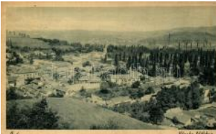
21284. ✳ Ózd (ázott / wet damage) T4 1000
