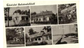
20182. ☒ Balatonlelle, Viga-dó, Tulipán csárda T2 1000
