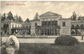
22611. Bad Ischl, Kaiser villa (wet damage) T4 1600
