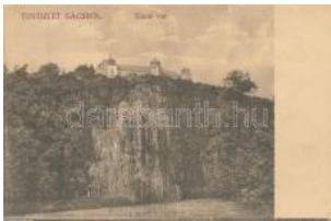
22095. Gács, vár / castle (wet damage) T4 1000
