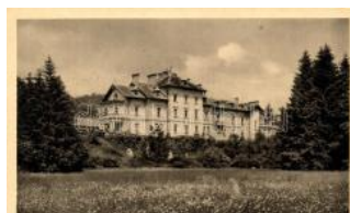
21300. Parádgyógyfürdő, Kastély szálló T2 1400
