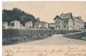
22605. Amstetten, Villenstrasse und neue Schustrasse 1000
