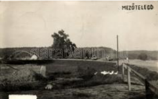
21900. ☒ Mezőtelegd, híd / bridge photo (fl) T2/3 1800
