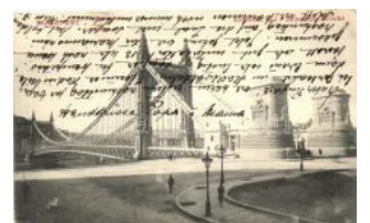
20294. * Budapest, Erzsébet híd (kis szakadás / s 1000
