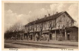
21104. ** Kisterenye, Bátor nyterenye; MÁV vasút 6000
