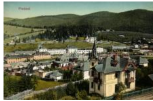
21933. ** Predeál, vasútállomás / railway station 1800
