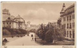
20823. ☒ Eger, Káptalan utca (Rb) T2/3 1200
