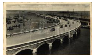
23266. ** Venezia, Venice, Ponte Littorio / bridge, T2 1000
