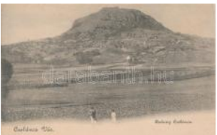
20759. ✳✳ Csobánc, Vár (áztott / wet damage) T4 1000
