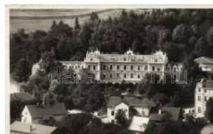
22844. * Brandys nad Orlicí sanatorium T2/3 800
