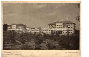
21452. ☒ Sopron, Lövér szálló (EB) T4 800
