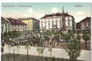
22015. ** Temesvár, Jenő herceg tér / square T2 2600
