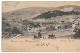
21304. 1899 Hinterbrühl (wet damage) T4 800
