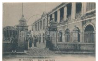
21547. Pondicherry, Casernes des Cipahis / barr 1600
