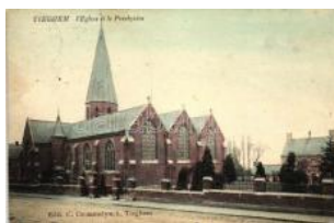
21392. Tiegem, Tieghem; Eglise, Presbytere / ch 1200
