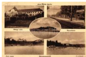
20147. ☒ Balatongyörök, B elügyi üdülő, Vasútállom 1400
