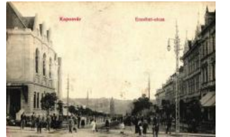
20417. ✱ Kaposvár, Erzsébet utca (ázott / wet dam) 1800
