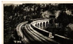
21356. ☒ Semmering, Viadukt über die Kalte Rinn 1400
