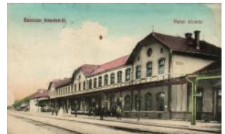
20161. ☒ Bánréve, Vasútál lomás T2/3 1600
