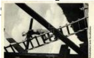
22997. ☒ Arbeitsdienst beim Barackenbau / work se 1600
