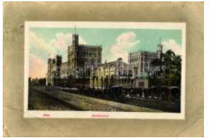
21371. Vienna, Wien; Nordbahnhof / North Railw 1200
