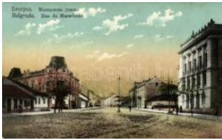
22070. Belgrade Rue de Macedonie / street (Rb) 1200
