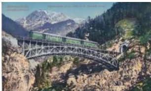
21354. ** Schlossbachbrücke der Mittenwaldbahn 1000
