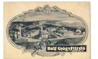
20157. ☒ Balf gyógyfürdő (ázott / wet damage) T3 1200
