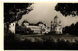
20704. ** Csíkszereda, M egyeháza / county house 900
