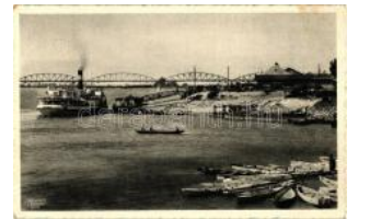
20109. ☒ Baja hajóállomás, gőzhajó, híd T2 2400
