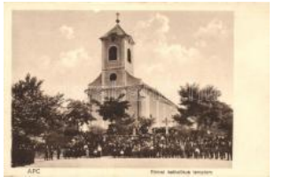
20095. ** Apc, Római katolikus templom (Rb) T2 2000
