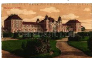
20562. ** Debrecen, indóház, vasútállomás T1/2 2800
