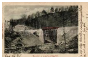
20552. ☒ Cuha-völgy, Vasúti híd; Köves Béla kiadá 1000
