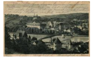
22508. ☒ Passau, Hindenburgbrücke, Kaserne / B 1000
