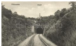
21042. ** Piliscsaba, Vasúti Alagút (EB) T3 1800
