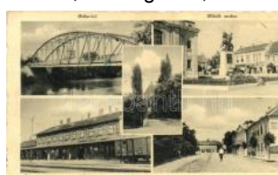
21080. * Sárvár, Rába híd, Korona szálló, Vasútáll 1400
