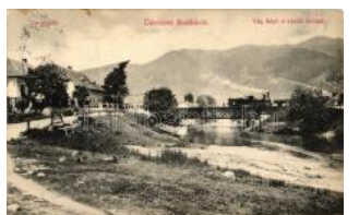
21838. ☒ Ruttká, Vág folyó , vasúti híd / river, railw 8000
