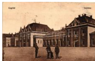
20547. ☒ Cegléd, Indóház, vasútállomás T2 1800
