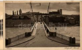
22504. ☒ Passau, Luitpoldbrücke / bridge (EK) T2 1200
