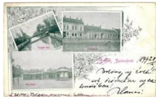
21094. ☒ 1899 Siófok, Bala tonfürdő, Vasúti híd, Fő 6000
