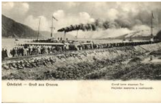
21533. ** Orsova, Hajózási csatorna a Vaskapun 2000
