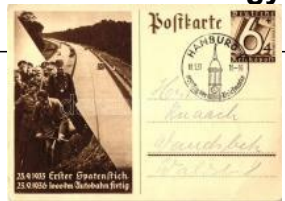
23292. ☒ 1933 Erster Spat enstich - 1936 1000 km 1400
