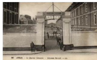
22314. ** Arras, Schramm barrack T2/3 2000
