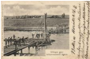
23021. Schlagen einer halbpermanenten Brücke / 800
