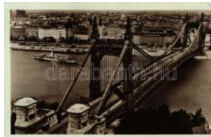
20270. ☒ Budapest, Erzséb et híd (EK) T2/3 800
