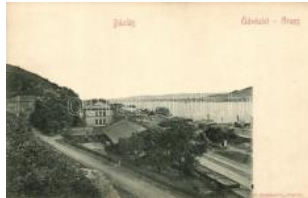
21398. * Bázias, vasútállomás / railway station T2 2000
