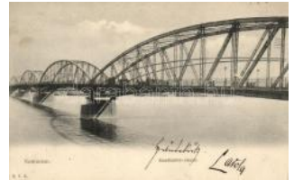
21736. ☒ Komárom, Erzsébet híd / bridge T2 1600
