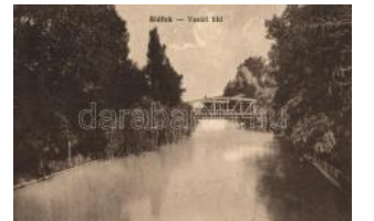
21096. ☒ Siófok, Vasúti híd (ázott / wet damage) T 1000
