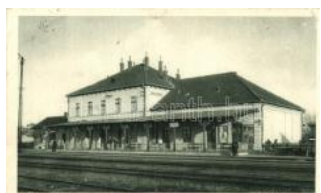
20950. Nagykőrös, pálya udvar, vasútállomás (E) 1800
