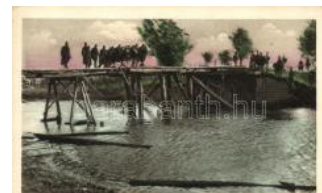
23378. ** Truppenübergang auf improvisierter Brücke 1400
