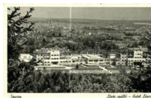
21032. ☒ Sopron, Lövér szálló (EK) T2/3 800
