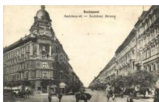
20468. ☒ Budapest VI. And rássy út (ázott / wet dam) 1000
