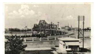
21778. ✱ Újvidék, Pétervárad híd / bridge T2 900
