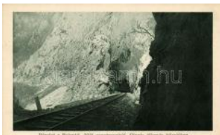
22780. ** Belgrade-Nisi v asútvonal, Gjunis vasút 1400
