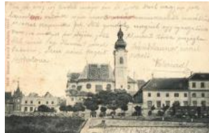
20725. ☒ Győr, Kármeliták épülete, tehervagonok 1400
