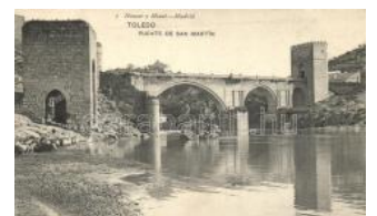
22742. ✱✱ Toledo, Puente de San Martín / bridge 1400
