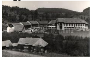
21944. ** Puyehue, Termas de Puyehue / spa house 1000
