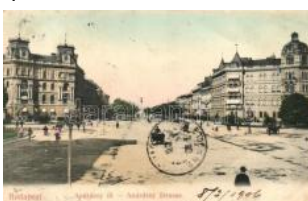
20467. ☒ Budapest VI. And rássy út (ázott / wet dam) 1000
