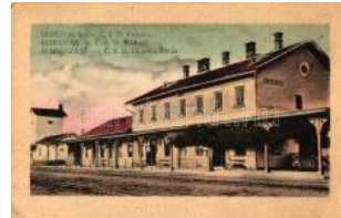
21634. * Beregszász, vasútállás / railway station, S6000
