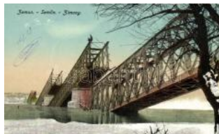
21820. * Zimony, A felrobbantott Száva híd / blow 1400
