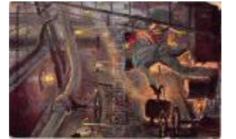
23174. ** Im Heizraum eines Schlachtschiffes. / 2000
