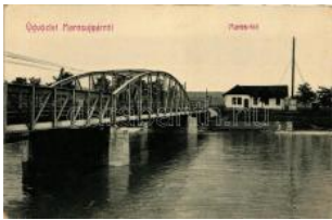
21271. ** Marosújvár, Maros-híd / bridge (EK) T2 3000
