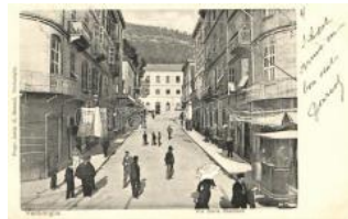
22653. ☒ Ventimiglia, Via della Stazione / street, h 2000
