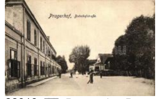
22818. ☒ Pragersko, Pragerhof; Bahnhofstrasse / r 2200
