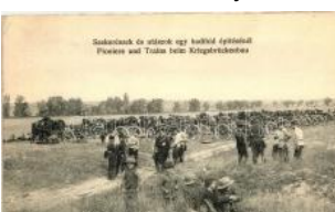
23571. ** Szerkesztők és utászok egy hadihíd építésénél 2000
