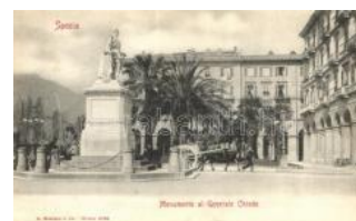
22538. ** La Spezia, Mon umento al Generale Ch 1400
