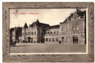
21293. ☒ Nagyvárad, vasútállomás / railway statio 2000
