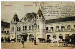
21295. ☒ Nagyvárad, vasúti indóház, Benkó Artúr 2000
