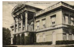
20158. Bajna, Herceg M. etternich-kastély (EB) T 1800
