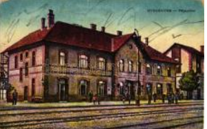
20679. Gyékényes, pálya udvar, vasútállomás (E 1400
