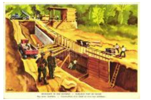
23473. ** Irgendwo in der Schweiz, Bau einer Ta 1600
