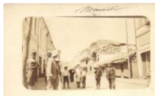
22256. ✱ Bitola, Monastir; Rue du Roi Pierre / street 3000
