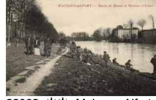
22062. ** Maisons-Alfort, Bords du Marne, Moulin 2000
