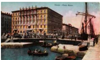
23282. ** Trieste, Ponte Rosso, Canale / canal, bridge 800
