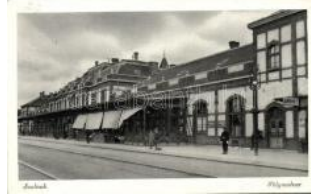
21304. ☒ Szolnok, pályaudvar, vasútállomás (EK) 1000
