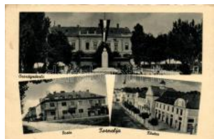
22004. ☒ Torna, Országgyűlési épület, Posta, Fő utca / 1200
