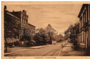
23092. * Castrop, Amtsgerecht u. Wittenerstrasse 1000
