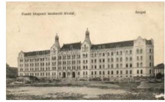
21197. Szeged, vasúti központ T2 2400
