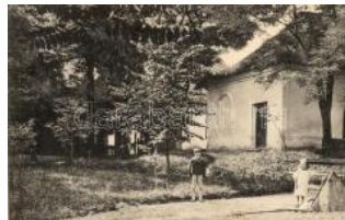
21436. ✳ Algyógyfürdő, Bo nremissza sor / street T 2200
