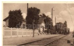
20141. ☒ Balatonszárszó, vasútállomás, sínautóbusz 2800
