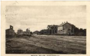
20148. ☒ Bányhida, vasútállomás vágányhálózata, 4600
