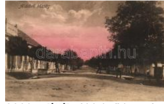
20097. ** Aldebrő község háza (ázott / wet damage) 800
