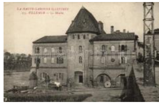
22803. ** Villemur, Le Moulin / mill (wet corner) T 2400
