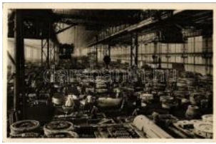
231114. Essen-Borbeck, Krupp Gusstahlwerk / f 1400
