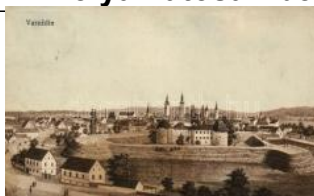
22172. ☒ Varasd, Varazdin ; (ázott / wet damage) T 1200
