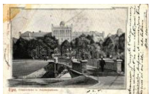
22927. ☒ Riga, Timmbrücke, Polytechnikum (fa) T 1200
