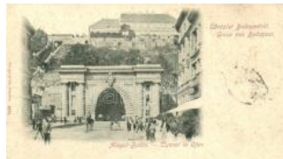
20283. ☒ 1897 Budapest I. Alagút, Takarékpénztár 1600
