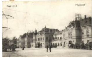
21639. * Nagyvárad, Vasútállomás / railway statio 1400
