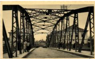
22059. ** Munkács, Híd / bridge T1/2 1200
