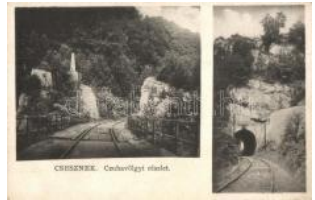
20616. ✳✳ Csesznek, Cuha-völgyi vasúti alagút T 1200
