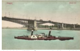
21183. Szeged, Közúti híd, SS Luitpold (EB) T3 1800
