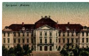
20685. ** Eger, Líceum (ázott / wet damage) T3 800
