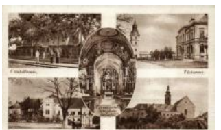
21174. ** Szécsény, vasútállomás, Tűztorony, ka 1000
