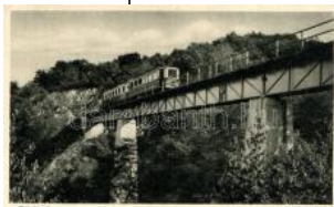
20890. * Lillafüred, Viadukt, vonatot (EK) T2/3 1600
