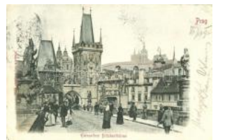
22645. ☒ Praha, Prag; Klei nseitner Brückenthürme 1000
