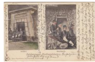
23057. ☒ Berchtesgaden, Salzbergwerk Ferdinand 1600
