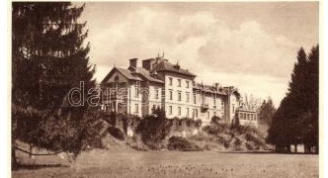
21149. ☒ Parád-gyógyfürdő, Kastély szálló T1/2 800
