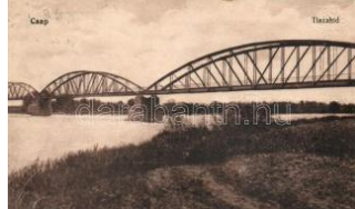
21953. ✳ Csap, Tiszahíd / b ridge (wet damage) T3 1400
