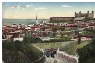
21861. ☒ Pozsony, Alagút, gőzmozdony / tunnel, I 3600
