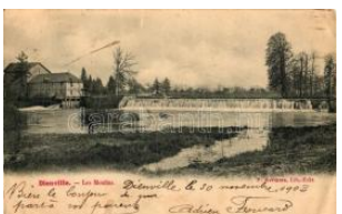
22386. ☒ Dienville, Les Moulins / mill (wet damage) 2000
