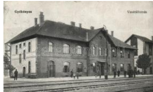
20839. Gyékényes, vasútállomás (kis szakadás) 3000
