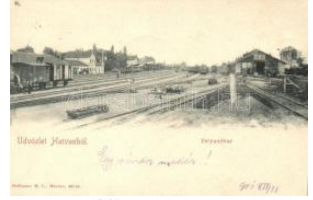
20885. ☒ Hatvan, vasútállomás (EK) T2/3 2800
