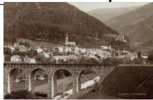
22235. ** Landeck, Arlbergbahn / viaduct T2 1200
