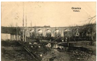
21610. Oravica, kiadja W eisz Félix / viaduct (EK 1800
