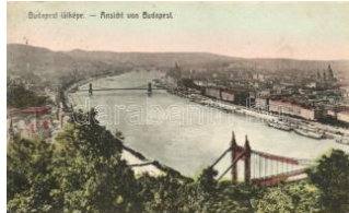
20223. Budapest, No. 1. (ázott / wet damage) T 1000
