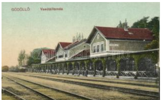
20818. Gödöllő, Vasútállomás T1 2000
