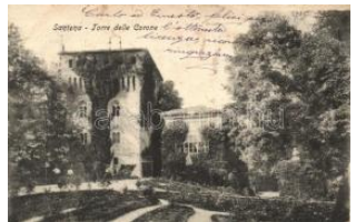
22931. * Santena, Torre delle Corone / tower (EB) 1400
