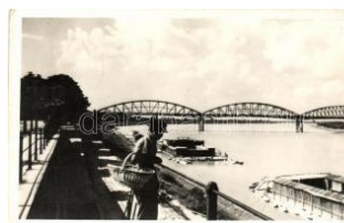
22100. ☒ Zenta, Tisza-híd / bridge (fa) T4 1000
