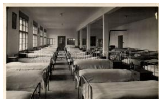
21121. ✱✱ Nyergesújfalu, Szalézi Intézet, Segítő sz 1200
