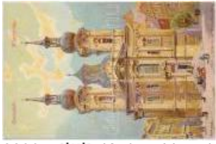
22334. Karlovy Vary, K arlsbad; Pfarrkirche / ch 1200
