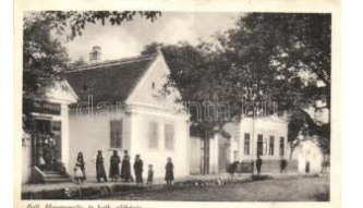
20181. * Balf, Hangya szöv etkezeti üzlet, Katolikus 3000
