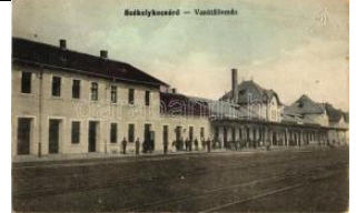
21661. * Székelykocsárd, vasútállomás / railway st 1800
