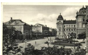
20854. Győr, vasútállomás T2 1000
