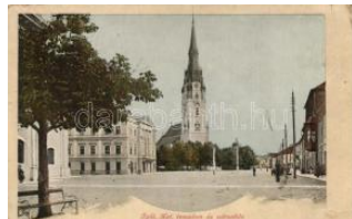
21737. ✱✱ Igló, Katolikus t emplom, Városháza; Fe 1200
