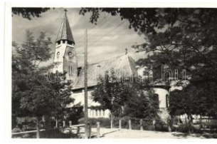
21420. ☒ Zebegey, Római katolikus templom (EK) 1600
