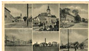
21883. * Somorja (ázott / w et damage) T4 800
