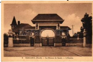
22337. ✳ Bailleul, Maison de Santé, entrée / entry 1600
