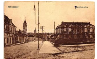
21602. * Petrozsény, Templom utca / church (cut) 2000
