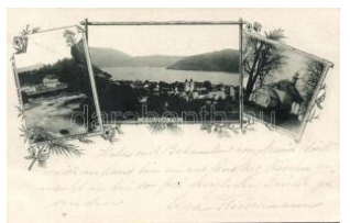
22128. 1898 Millstatt, Eiserner Brücke, Calvarien 2000
