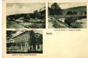
21605. ** Rescabánya, Resica; Stávila híd, állam 2200
