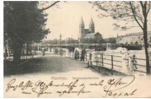
22699. München, Reichsbrücke / bridge (E) 1800
