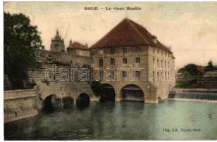
22346. ☒ Dole, Le vieux Moulin / old mill (EB) T3 2000
