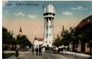
21163. ** Siófok, Fő tér, Víztorony (kis szakadás) 2800
