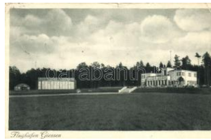
22635. ☒ Giessen, Flughafen Gießen (small tear) 1800
