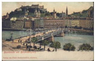
22136. ** Salzburg, Stadtbrücke, Hohen-Salzburg 1600
