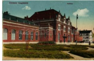
20639. Cegléd, Indóház, vasútállomás (EK) T2/ 1000
