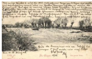
21616. ☒ Szászrégen gát / dam T2 2400
