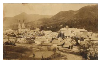
21516. ** Felsőbánya, Balia Sprie; Vagányi photo 1400
