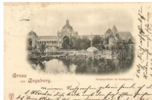
22570. ☒ Augsburg, Hauptgebäude im Stadtgarte 1200
