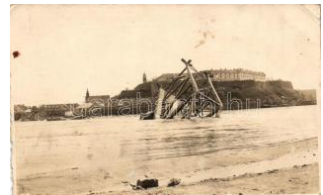
21966. ✱✱ Újvidék Pétervárad, Felrobbantott híd / 2600
