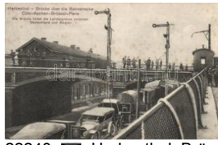
22240. ☒ Herbesthal, Brücke über die Bahnstrecke 1600
