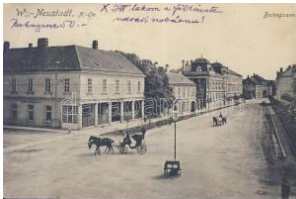
22212. * Wiener Neustadt, Bahngasse / railway st 2200
