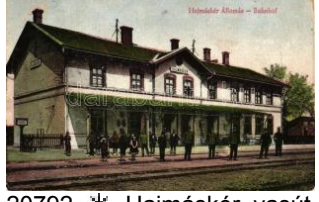
20792. ✱ Hajmáskér, vasútállomás (Rb) T3 6000
