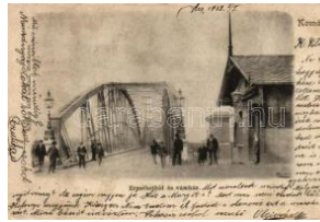
21662. ☒ Komárom, Erzsebet híd, Vámház / bridg 2000
