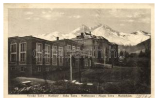
21842. Tátra, Matlárháza (wet damage) T3/4 2600
