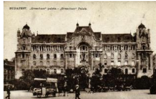
20322. ✳✳ Budapest V. Gresham-palota, lövasút ( 1800
