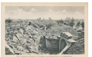
23404. ** Von unseren schweren Mörsern zerstört 2000
