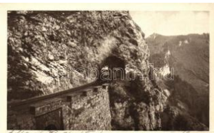
22392. * Weinzettelwand tunnel, Semmeringbahn r 1200
