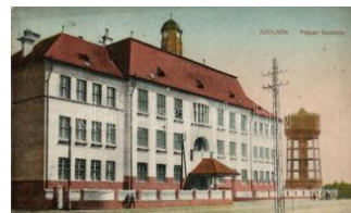
21075. ✱✱ Szolnok, Polgári fiúiskola, víztorony (fl) 1600
