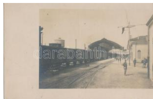
22702. ☒ Udine, Bahnhofsh alle; Verlag Karl Harbau 2200
