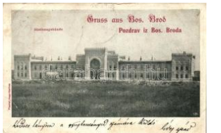
22401. ☒ Brod (Bosanski Brod), Stationsgebäude 1400
