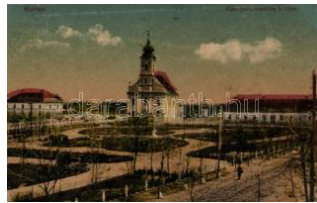
20665. * Hatvan, Római katolikus templom, tér T2 1000
