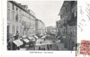
22774. ☒ Ventimiglia, Via C ; avour / street, tram (fa) 3000
