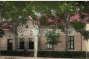
21349. * Margitta, vasútállomás / railway station (E 7000)
