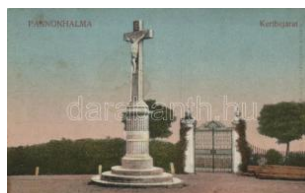
20914. ☒ Pannonhalma kertbejárat (fi) T2/3 1000
