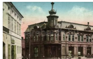
21459. * Szászváros, Broos; (wet damage) T4 3200
