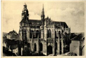
21628. ** Kassa, dome (c ut) T4 800
