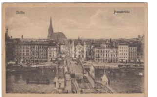
22536. ** Szczecin, Stettin; Hansabrücke / bridge 1200
