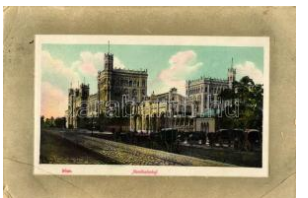
22385. ☒ Vienna, Wien; No rdbahnhof / North Railw 1200
