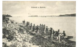
23187. * Utászok a Száván / construction unit (Rb) 1600
