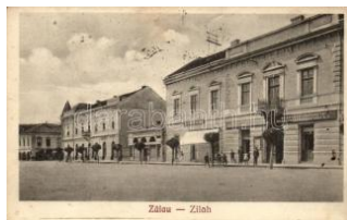
21916. ☒ Zilah, takarékpénztár / savings bank, vis 1000
