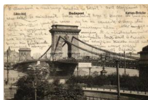
20349. Budapest, Lánchíd, 'Vámház Az első álló 1400
