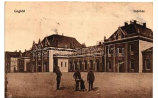
20686. ☒ Cegléd, Indóház, vasútállomás T2 1800
