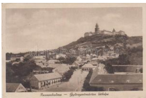
21211. ✖✖ Pannonhalma, Gyórszentmárton (ázot) 1000
