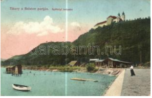
21519. ☒ Tihany, Apátsági kolostor (kis szakadás / 900
