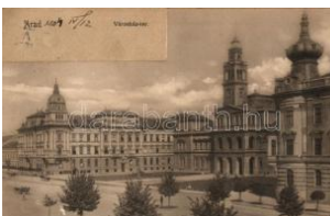
21657. * Arad, Városház tér / town hall, square (glue) 900
