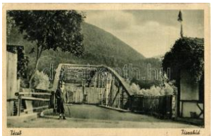
22207. ☒ Técső, Tisza híd / bridge (EB) T3 2800
