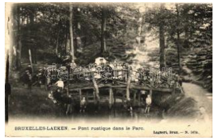
22444. Brussels, Bruxelles; Laeken, Pont rusti 1400
