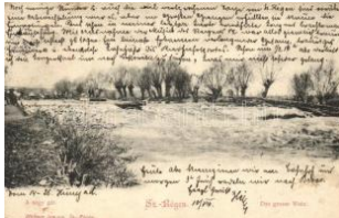
21861. ✉ Szászrégen gát / dam T2 1200
