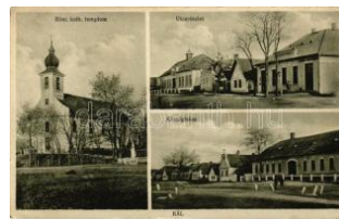
20958. ** Kál, Katolikus templom, Hanga szövet 1600
