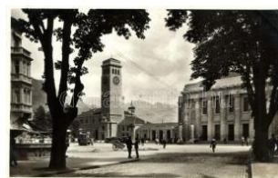
22816. ** Bolzano, Bozen; Stazione / railway stat 1600
