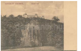
21967. ☒ Gács, vár / castle (wet damage) T4 1000
