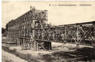
23605. * Korneuburg, Kohnbrücke. K.u.k. Eisenbah 3800
