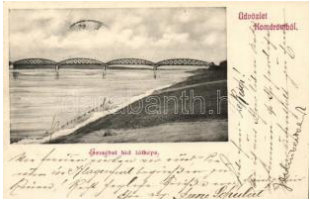
22027. ☒ Komárom, Erzsébet híd / bridge T2 1600
