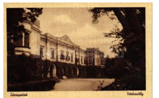
21305. ☒ Sárospatak, Várk astély (ázott/wet damage) 800
