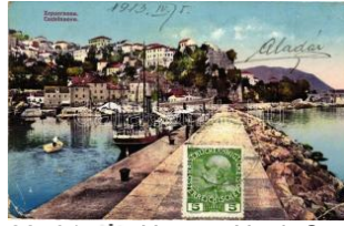
22701. ✱ Herceg Novi, Cas telnuovo; port (EK) T3 1200
