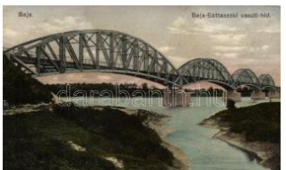
20143. ** Baja-Bátaszék v asúti híd, Wurmfeld Gy 2800
