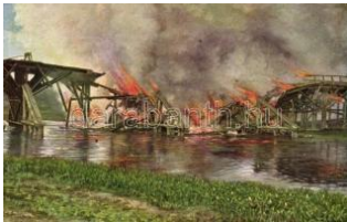
23595. ** Brückensprengung auf dem russischen 1400
