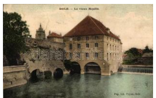
22532. ☒ Dole, Le Vieux Moulin / old mill (EB) T3 2000
