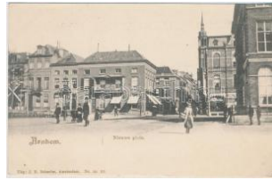
22577. ** Arnhem, Nieuwe plein / new square T2 1200
