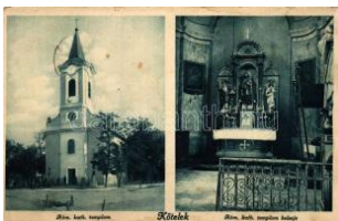
20808. * Kőtelek, Római katolikus templom belső T 1000
