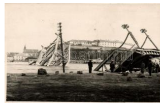
21894. ** Újvidék Pétervárad, Felrobbantott híd / 1600
