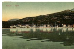
22246. ☒ Igalo (wet damag e) T4 1000
