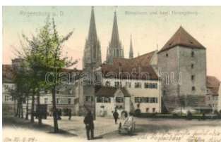
22372. ✉ Regensburg, Römerturm, byr. Herzogsbü 1600
