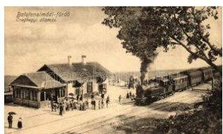
20161. ☒ Balatonalmádi-fü rdő, Öreghegyi vasútáll 8500
