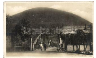
21747. ** Técső, Tacovo; híd / bridge (EK) T2/3 1400
