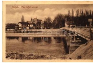
21630. ☒ Pöstyén, Vág foly ó, híd / river, bridge (EK) 1600
