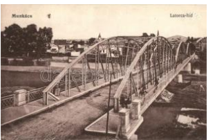
21732. ✱ Munkács, Latorca híd / bridge T2 2000
