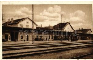
20704. ☒ Hatvan, vasútállomás (EB) T3 1400
