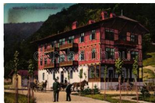
20813. ** Lillafüred, Vendéglő (ázott / wet damag 1400
