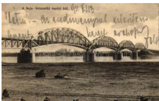
20132. ☒ Baja-Bátaszéki vasúti híd; ifj Wagner An 6000
