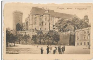
22137. ** Kraków Wawel király kastély / Crackow 1600
