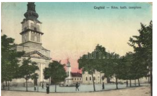
20441. ☒ Cegléd, Katolikus templom (fa) T3 1600
