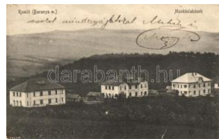
20710. ✱ Komló, Munkáslakások (EB) T3 2800
