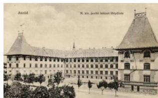
20141. ☒ Aszód, M. kir. javító intézet főépülete (EB2000
