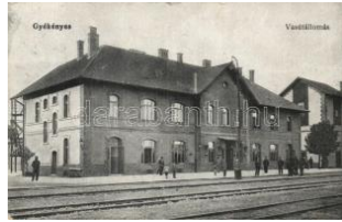
20565. * Gyékényes, vasútállomás (kis szakadás) 3000
