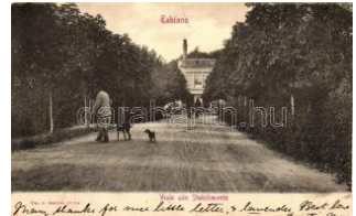
22410. ☒ Tabiano, Viale allo Stabilimento / avenue 800
