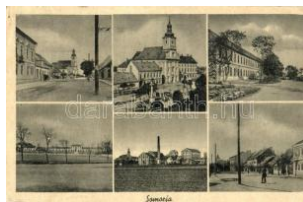
21504. ✳ Somorja (ázott / w et damage) T4 800
