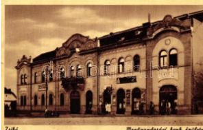
21335. Zsibó, Mezőgazdasági Bank épülete 2000
