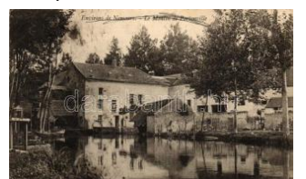
21994. ☒ Nemours, Le Moulin de Portonville / mill 2000
