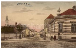
21715. Lajtabruck, Bruck and der Leitha; Wiener 4000
