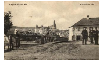
21322. ☒ Vajdahunyad, Vasúti híd / iron bridge, c 2800
