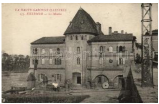
22023. ** Villemur, Le Moulin / mill (wet corner) T 2400
