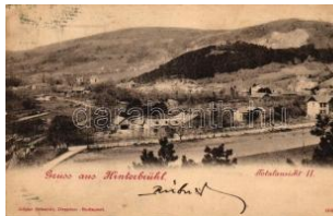
21817. 1899 Hinterbrühl (wet corner) T3 800
