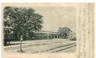
21435. ☒ Komárom-Újszóny, vasútállomás, Sipos 6500
