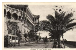
22345. ✨ Genova, Corso Aurelio Saffi, tram T1/2 1800
