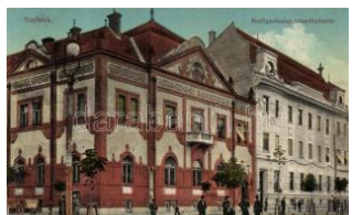
21052. ☒ Szolnok, mezőgazdasági takarékpénztár 2600
