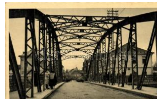
21686. Munkács, Híd / bridge T1/2 1200
