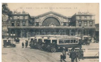
22299. ** Paris, Gare de l'Est. Entrée du Métrop 1200
