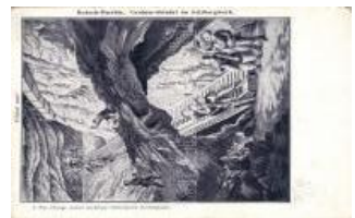
22534. Berchtesgaden, Salzbergwerk, Rutsch 1400
