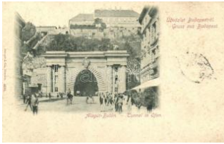
20275. ☒ 1897 Budapest I. Alagút, Takarékpénztár 1600
