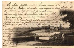
22317. * Poilly, Moulin de Marcault / mill (wet dam 1200
