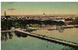
21819. ✳✳ Újvidék, híd / bridge (ázott) / wet damage 800
