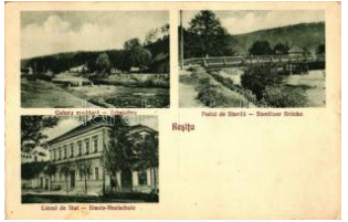
21297. ** Resicabánya, Resica; Stávila híd, állam 2200
