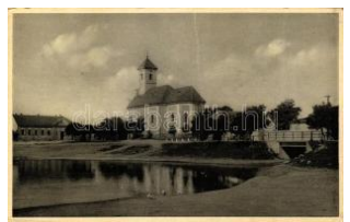
21406. ☒ Felsőszeli, Római katolikus templom, Du 2200
