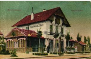
20131. Balatonalmádi, vasútállomás; Rády István 5500
