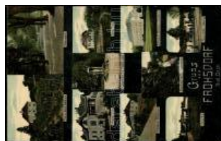
22012. * Frohsdorf, Post und Gebäude, Schloss 1400
