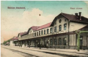
20185. Bánréve, Vasútá lomás T2/3 1600
