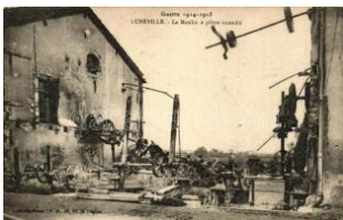
22275. Lunéville, Moulin a platre incendie / destr 3000
