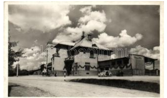
21848. Rimaszombat, új vasútállomás épülete 2200
