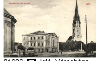
21696. Igló, Városháza, katolikus templom / tow 1600
