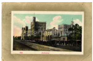
22171. ☒ Vienna, Wien; Nordbahnhof / North Railw 1200
