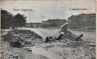
21462. ** Lugos, Árvíz; a vasbetonhid martaléka 4000
