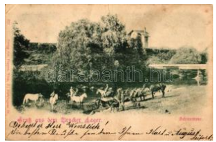
22055. ☒ Lajtabruck, Bruck and der Leitha; Brücke 2000
