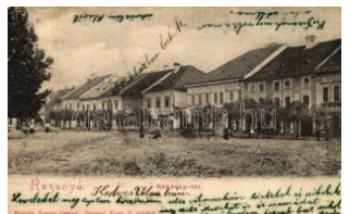
21856. Rozsnyó, Rákóczi tér, építkezés; kiadja P 2000
