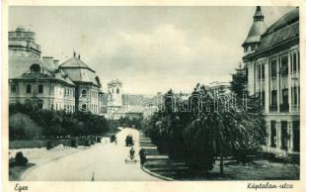
20625. * Eger, Káptalan utca (Rb) T3/4 1000
