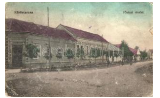
20804. * Köröstarcsa, Fő utca (ázott / wet damage) 1000
