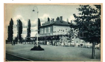
20232. ☒ Balatonföldvár, Vasútállomás (b) T4 1000
