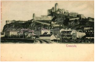
21901. ** Trencsén, vár, vasút / castle, railway T1 1600
