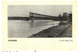
22042. ☒ Újvidék, volt vasúti híd / destroyed railwa 1800
