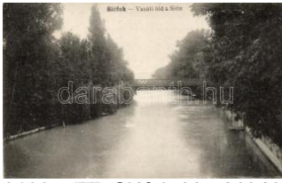
21037. Siófok, Vasúti híd a Sión T2 1600
