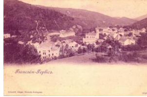
21911. ** Trencséntéplóc (ázott / wet damage) T4 1000
