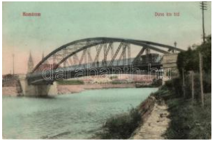
21745. ☒ Komárom, Duna kis híd / bridge T2 3600
