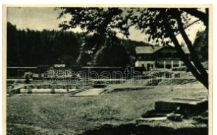
21317. Bánffy-fürdő / spa (ázott / wet damage) T4 800
