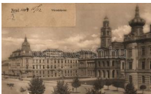
21309. Arad, Városház t- ér / town hall, square (glue) 900
