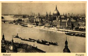
20438. ☒ Budapest V. Országház (ázott / wet damag) 800
