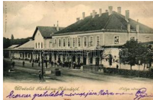
21814. ☒ Párkány, Va sútállomás / railway sta 4400
