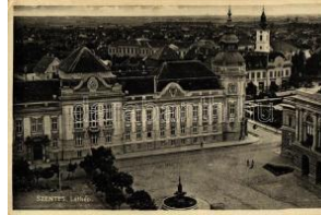
21139. Szentes, Petőfi szálló (ázott / wet damag) 1000
