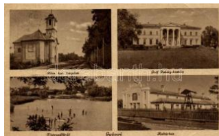
20686. ☒ Gyömrő, Gróf Teleky kastély, Kultúrház 1200
