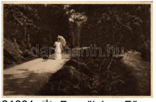
21681. Fenyőháza, Fűzes út / alley (ázott / wet) da 800
