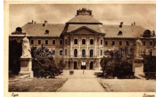
20623. ☒ Eger, Líceum (ázott / wet damage) T4 800
