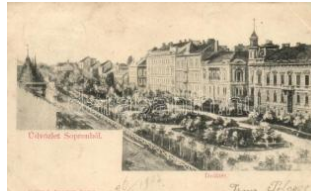
21074. ☒ Sopron, Deák tér (ázott / wet damage) T 2400
