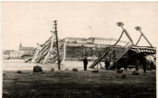
22096. ** Újvidék Pétervárad, Felrobbantott híd / 1600
