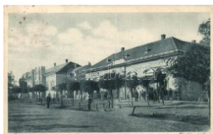
20756. 📦 Jászárokszállás, Főter, Hangya Szövetk 1200
