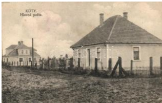
21676. ✉ Jókút, Kúty; Posta / Post Office (EB) T3 6000
