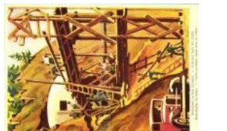
23513. ** Irgendwo in der Schweiz, Beton-Bunker 1600
