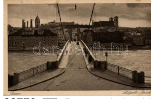
22770. ☒ Passau, Luitpoldbrücke / bridge (EK) T2 1200
