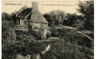
22430. ** Dol-de-Bretagne, Moulin / mill T2 1200
