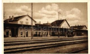
20709. ☒ Hatvan, vasútállomás (EB) T3 1400
