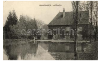
22451. Marchaux, Le Moulin / mill T2 1800
