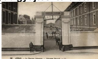
22410. ** Arras, Schramm barrack T2/3 2000
