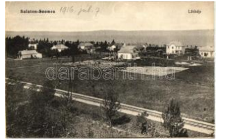
20179. Balatonszemes (kis szakadás / small te 1600
