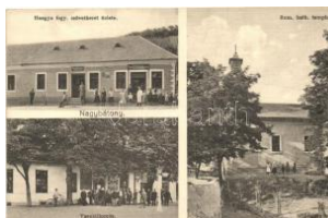
20898. ✱✱ Nagybátony, va sútállomás, Hangya szűz 5000
