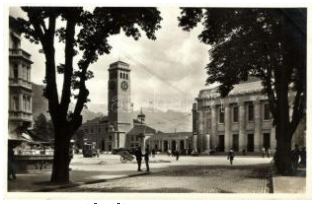
22808. ** Bolzano, Bozen; Stazione / railway stat 1600
