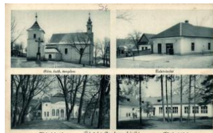
21626. Barsbaracska, Barsbaracska; Római Katolikus 4000
