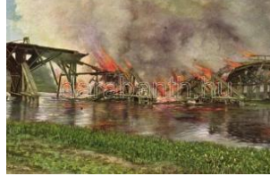
23538. ** Brückensprengung auf dem russischen 1400
