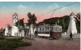
21600. * Temesvár, Timisoara; Új Bega híd, villam 4400
