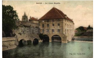
22431. ** Dole, Le vieux Moulin / old mill (EB) T3 2000
