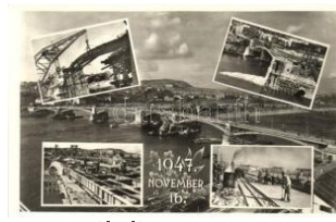
20281. ** 1947 Budapest, A Margit híd építése T 2000
