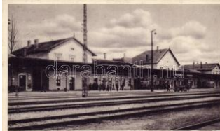
20708. ☒ Hatvan, vasútállomás (EK) T2/3 1400
