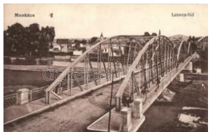
21934. * Munkács, Latorca híd / bridge T2 2000
