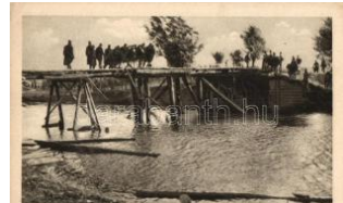
23511. ** Truppenübergang auf improvisierter Brücke 1600
