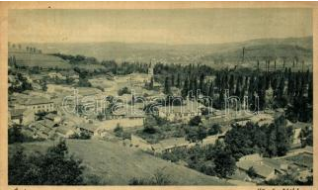
20940. * Ózd (áztott / wet damage) T4 1000
