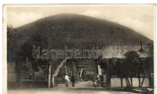
21946. ** Técső, Tacovo; híd / bridge (EK) T2/3 1400
