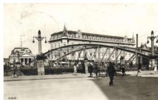
21506. ☒ Nagyvárád, Oradea; vasúti híd / railway 5000
