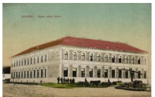
20754. ** Isaszeg, Állami elemi iskola T1/2 1600
