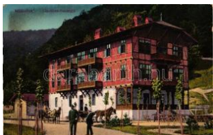
20829. Lillafüred, Vend églő (ázott / wet damag 1400
