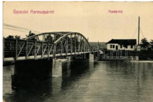
21462. ✳✳ Marosújvár, Maros-híd / bridge (EK) T2 2200
