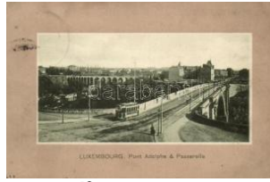
22180. * Luxembourg, pont Adolphe, Passarelle / 1800
