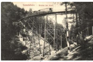
21814. ☒ Stubaitalbahn, Brücke bei Kreitt / railway 2000
