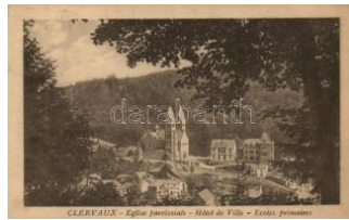
22171. ☒ Clervaux, Eglise paroissiale, Hotel de Vi 1600
