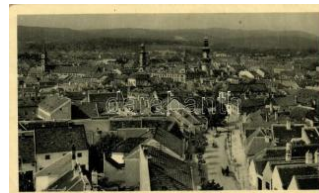
20837. * Sopron, utca (ázott / wet damage) T4 900
