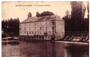
21961. ☒ Arcis-sur-Aube, B assin du Moulin / mill T 2200
