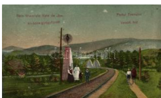
21004. * Alvácza-gyógyfürdő, Vasúti híd / railway b 2400
