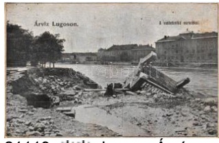
21119. ** Lugos, Árvíz; a vasbetonhid martaléka 4000
