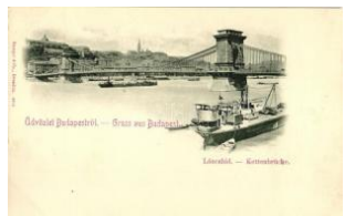
20209. ** Budapest, Lánc híd T1/2 1400
