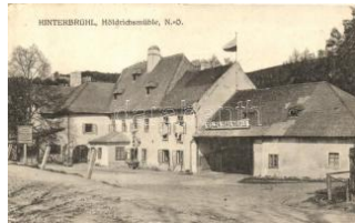
21761. ✉ Hinterbrühl, Höldrismühle / mill, cafe, 3000
