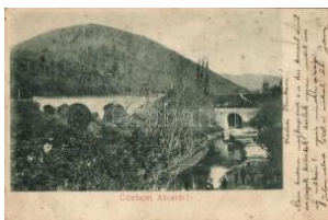
21260. ☒ Abos, híd / bridge (EB) T3 2000
