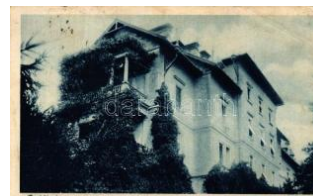
20765. Parádfürdő, kastély (ázott / wet damage) T 800
