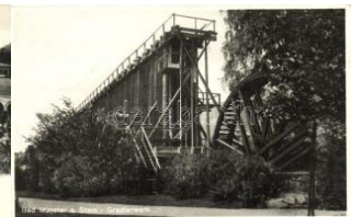
22281. Bad Münster am Stein, Gradierwerk / sa 2000
