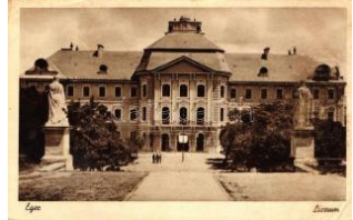
20488. ☒ Eger, líceum (ázott / wet damage) T4 800
