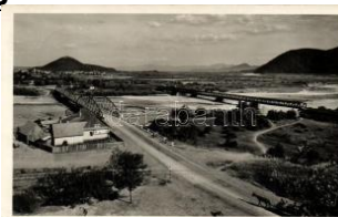
21500. Huszt, hidak / bridges (EK) T2/3 1000
