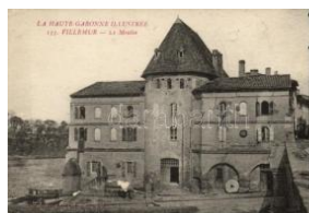
22068. Villemur, Le Moulin / mill (wet corner) T 2400
