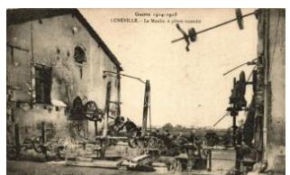
21995. * Lunéville, Moulin a platre incendie / destr 3000
