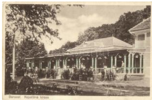
21567. ☒ Daruvar, fürdő te rasz / spa terrace T2 1400
