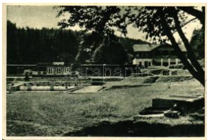
21018. ✱ Bányffy-fürdő / spa (ázott / wet damage) T4 800
