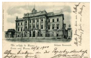
21570. ☒ Fiume, Palazzo G overniale / palace (EK) 1200
