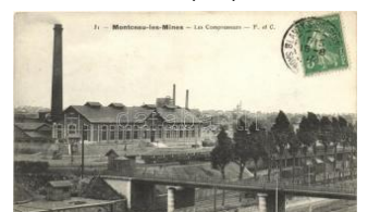
22059. ☒ Montceau-les-M ines, Les Compresseurs 3600
