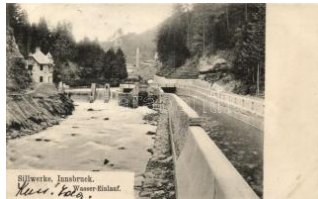
21777. ☒ Innsbruck, Sillwerke, Wasser-Einlauf / d 1600
