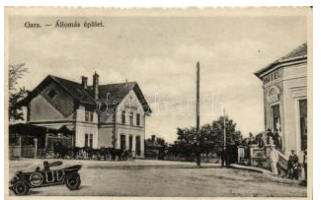
21153. ✱ Marosújvár, Ocna Mures; vasútállomás, s 7000
