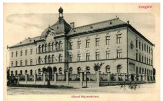
20445. ☒ Cegléd, Állami Fő gimnázium (EK) T2/3 1000
