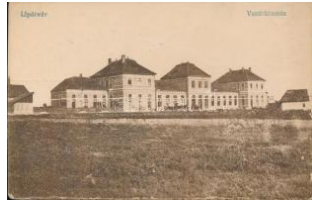
21369. ** Lipótvár, Vasúti Illomás / railway station T 800
