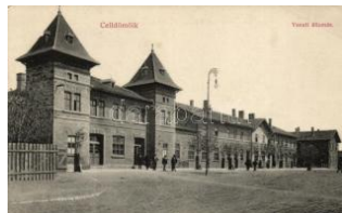
20446. ✱ Celldömölk, vasút állomás (EK) T2/3 4000
