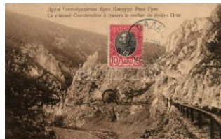
22655. ☒ Cestobrodica, river, tunnel (EK) T2/3 1200
