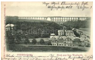
22417. Göltzschtalbrücke, Göltzsch Viaduct; Vog 2600
