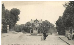
22041. ** Le Vésinet, Rue Lafontaine, Rue Thiers 2200
