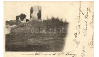
22039. ☒ La Souterraine, T our de Bridiers / tower T 1600
