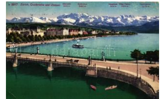
22644. ☒ Zürich, Quaibrücke und Utoqual / bridge, 1000
