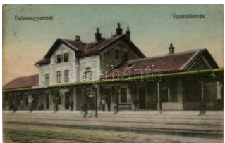
20136. Balassagyarmat, Vasútállomás (EK) T2/ 3600
