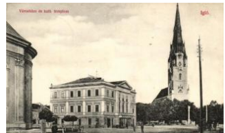
21303. ☒ Igló, Városháza, katolikus templom / tow 1600
