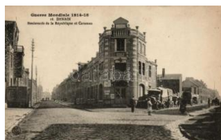
22018. * Denain, Boulevards de la Republique, C 2200
