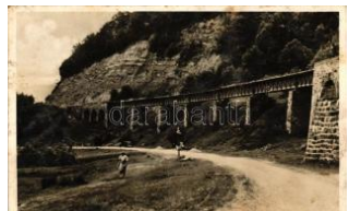
21535. ☒ Uzsok, Viadukt / viaduct (EK) T2/3 1400
