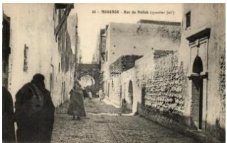
22360. * Essauira, Mogador; Rue du Mellah, q 3000
