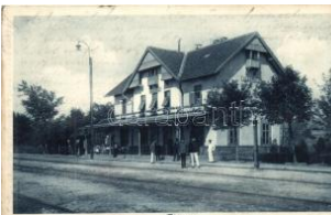
20100. ✳ Alsóórs, vasútállomás (ázott / wet damage) 1200
