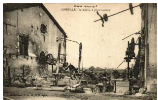
22061. * Lunéville, Moulin a platre incendie / destr 3000
