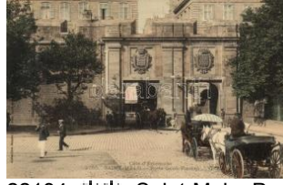
22134. Saint-Malo, Porte Saint-Vincent / gate T1600
