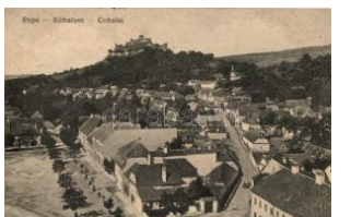
21193. ☒ Köhalm, Reps; ( ázott / wet damage) T4 1600
