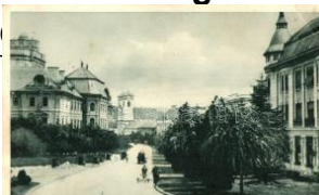
20538. * Eger, Káptalan utca (Rb) T3/4 1000
