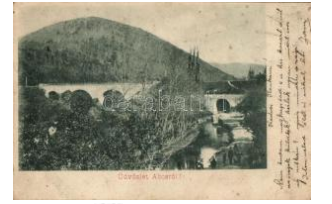
21347. Abos, híd / bridge (EB) T3 2000
