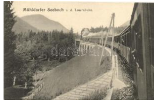
21842. ✱✱ Mühlendorf, Seebach, bridge, Tauern Ra 1200
