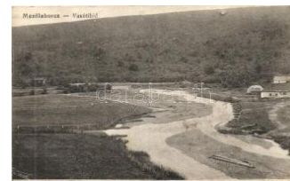
21495. ☒ Mezőlaborc, Medzilaborce; Vasúti híd / r 1600
