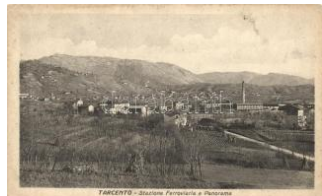
22513. ** Tarcento, Stazione Ferroviaria / railway 1600
