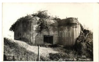
21965. ✱ Devet Mlynu, Neumuhlen; Betonbunker 2800
