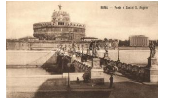
22503. ** Rome, Roma; Ponte e Castel S. Angelo 1200
