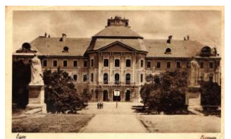
20526. ✳ Eger, líceum (ázott / wet damage) T4 800
