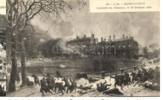
22131. Saint-Cloud, Incendie du Château in 1870 900
