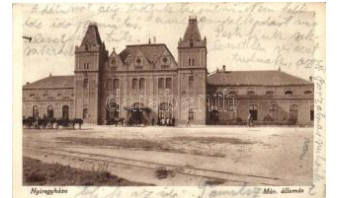
20819. ☒ Nyíregyháza, vas utállomás (vágott / cut) 1200
