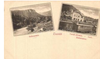
21335. Tusnád, Falkenstein, vasútállomás, vo 3000
