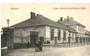
21460. ** Komárom, Komárom; Frigyes főherceg- 3000
