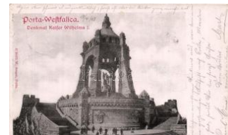
22399. ☒ Porta Westfalica, Denkmal Kaiser Wilhe 1600
