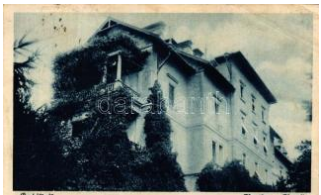
20836. ☒ Parádgyűrdő, kasté ly (ázott / wet damage) T 800
