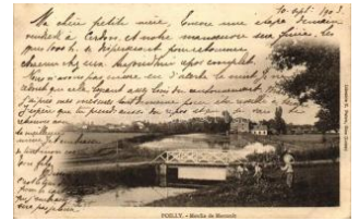
22111. Poilly, Moulin de Marcault / mill (wet dam) 1200
