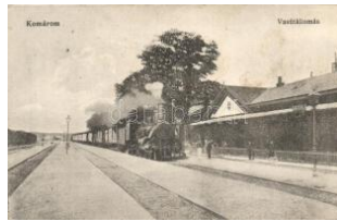
21466. ☒ Komárom, Komárno; vasútállomás gőzm 4000
