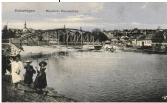
21304. Szászrégen, Reghin; Maros-híd / bridge 4000
