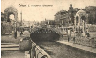
21894. Vienna, Wien I. Wienportal / tunnel (EK 1800
