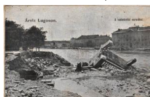
21206. ✱✱ Lugos, Árvíz; a vasbetonhid martaléka 4000
