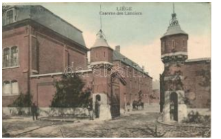
21967. 1 Liège, Caserne d es Lanciers / barracks T2200
