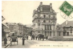
22141. ☒ Rive-de-Gier, Pont d'Egarande / bridge T1600
