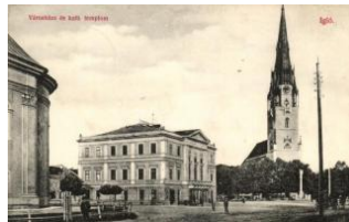
21165. Igló, Városháza, katolikus templom / tow 1600
