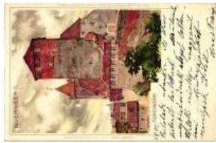
22532. Nürnberg, Fuenfkirger Turm / tower, Ve 3000
