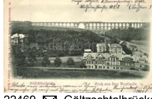
22469. ☒ Göltzschtalbrücke, Göltzsch Viaduct; Vog 2600
