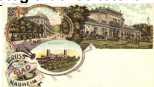
22412. * Bad Nauheim, Mühlentempel, Parkstrasse, 2600
