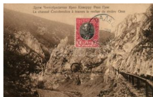
22845. ☒ Cestobrodica, river, tunnel (EK) T2/3 1200
