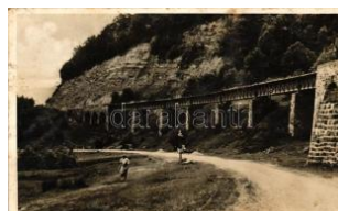
21373. Uzsok, Viadukt / viaduct (EK) T2/3 1400
