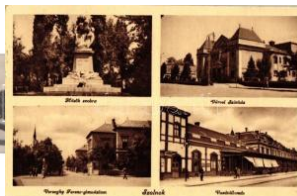
20849. ☒ Szolnok, vasúttáll omás, Verseygy Feren 1600
