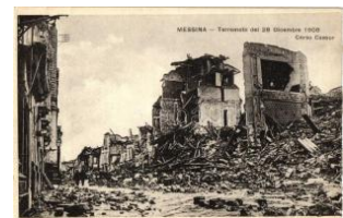
22630. 1908 Messina, Terremoto, Corso Cavo 2400
