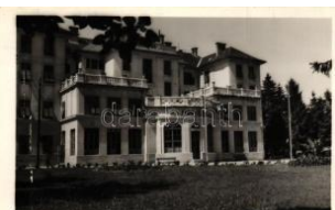
20132. ✱✱ Balatonföldvár, Kupavezer szálló T2/3 1000
