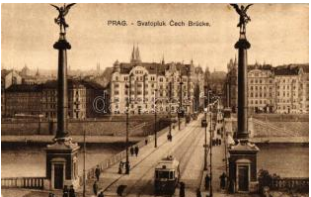
22031. ✨ Praha, Prag; Svatošluk Cech Brücke / b1400
