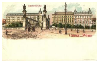
21828. Vienna, Wien; Augustenbrücke / bridge, 2600
