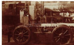
24337. * MÁV futómű / Ung. 'Nord' Repar. Work, B 2000
