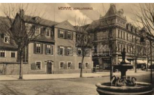
22563. ** Weimar, Schillerhaus T2 1600
