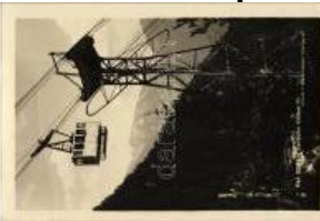
21772. ✳ Rax, Seilbahn Stütze II / cable car T1/2 1400
