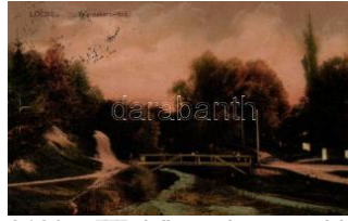
21234. ☒ Lőcse, Levoca; Városkerti-híd / bridge T22000
