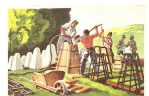
23261. ** Irgendwo in der Schweiz, Bau eines Hö 1400
