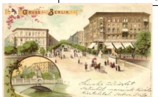
22462. ☒ Berlin, Herkules Brücke, Albrechtshof, C2600
