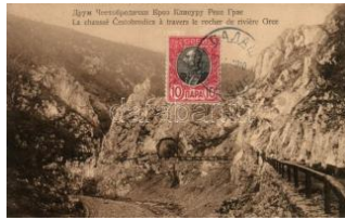
22755. ☒ Cestobrodica, river, tunnel (EK) T2/3 1200
