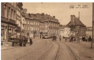
22157. ** Liège, Liège; Quai de Maestricht / dock 1000
