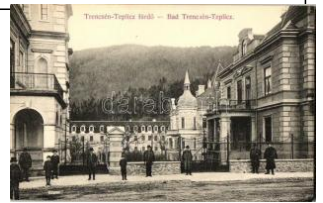
21627. ** Trencsénteplic-ürdő, Trencianske Tep 1800
