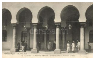
21841. ** Algiers, Nouvel le Prefecture / new pref 1600
