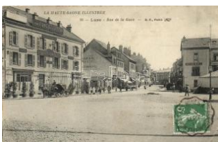
22261. ☒ Lure, Rue de la Gare, Hotel du Commerc 2000
