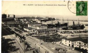
21797. ✳ Algiers, Alger; 'Les Quais et le Boulevard 1400
