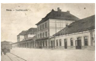
21396. ☒ Tövis, Teius; vasútállomás / railway stat 1000
