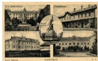
20627. ☒ Hajmáskér, E. 1. épület belső részlet, Va 1200
