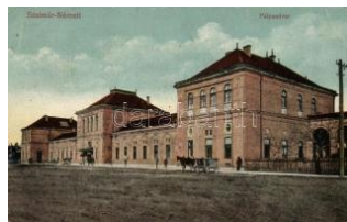
21365. * Szatmárnémeti, Satu Mare; vasútállomás 2000
