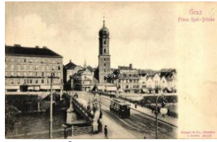
21922. * Graz, Franz Karl B rücke / bridge, tram T2 1400
