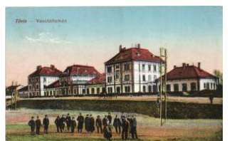
21395. ☒ Tövis, Teius; vasútállomás / railway stat 1000
