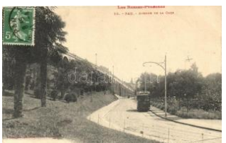
22285. ☒ Pau, Avenue de la Gare / funicular railwa 2000
