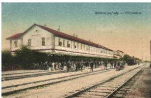
20925. * Sátoraljaújhely, vasútállomás, vonat (Rb) 1000
