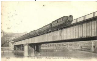
22265. * Lyon, Pont du chemin de fer sur la Saon 2000
