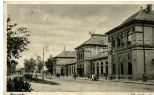
20707. * Kaposvár, vasútállomás (fa) T3 1200
