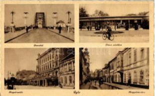
20576. ** Győr, Duna híd, Ibsz pavilon, Royal s 1200
