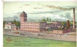
22499. ** Riesa, Gröba; S eifen-Fabrik, Grosseink 4000
