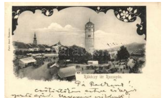
21575. ☒ Rozsnyó, Roznava; Rákóczi tér, Rákóczi 2200
