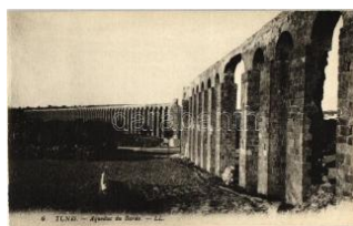
22779. ** Tunis, 'Aquaduct du Bardo' / Aquaduct o 1400
