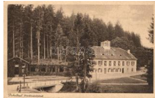
22022. ✳✳ Tobelbad, Döbelsbad; Ferdinandsbad / s 1200
