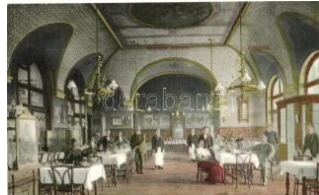
21062. ☒ Szeged, Vasútállomás, belső 16000
