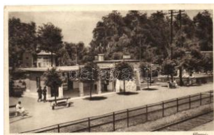
20087. Alsógöd, Vasútállomás T2/3 3600
