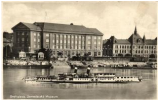
21693. P Pozsony, Bratislava; Mezűgazdasági Mű 2000
