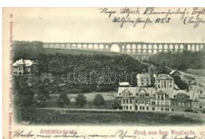
22639. ☒ Göltzschtalbrücke, Göltzsch Viaduct; Vog 2600
