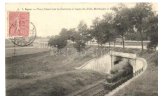
22149. ☒ Agen, Pont Canal sur la Garonne / bridge 1800
