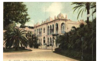
21936. ✱✱ Algiers, Alger; 'Palais d'Été du Gouverno 1200
