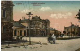
21039. ☒ Sopron, Déli vasúti pályaudvar (f) T3 1600
