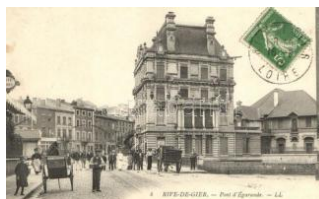
22371. ☒ Rive-de-Gier, Pont d'Égarande / bridge T1600
