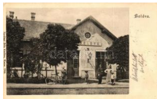
20182. ☒ Boldva, vasútállomás, hátoldalon a Had 14000
