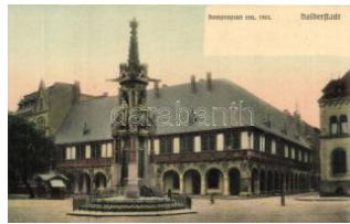
22643. Halberstadt, Dompropstei ren. 1903 / c 1400
