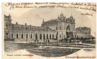
21141. ☒ Szombathely, Vassúti indóház homlokzata, 800
