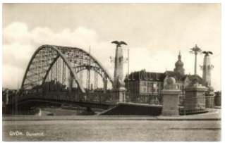
20681. ✳✳ Győr, Duna híd T2 1200
