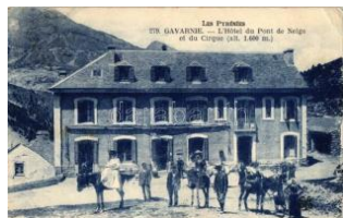
22220. ☒ Gavarnie, Hotel d u Pont de Neige, Cirqu 3000
