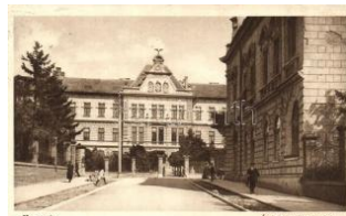
20779. ☒ Kaposvár, Állami reál gimnázium (ázott s) 1000
