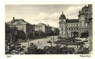
20684. ✳ Győr, vasútállomás T2/3 1600
