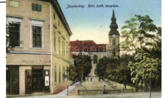
20756. ** Jászberény, Katolikus templom, Forgá 2000
