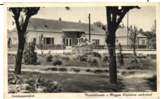
21204. ☒ Zamárdi, Balaton zamárdi; vasútállomás, 1400
