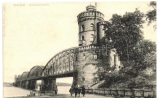
22702. * Mainz, Mainz; Eisenbahnbrücke / railway bridge 1400
