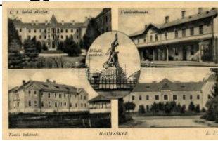
20604. 📦 Hajmáskér, E. 1. épület belső részlet, Va 1200
