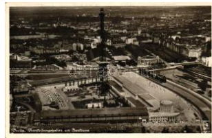
22305. Berlin, 'Aufstellungsgshallen am Funkturm' 1400
