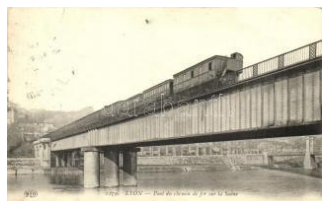
22158. ✨ Lyon, Pont du chemin de fer sur la Saone 2000
