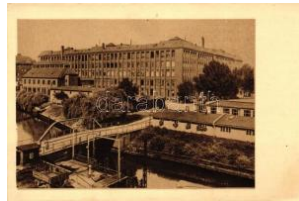
22306. ** Berlin, Siemensstadt, Kleinbauwerk / S 1200
