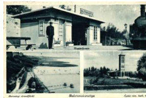
20097. ☒ Balatonakarattya, vasútállomás, épülő R 1200
