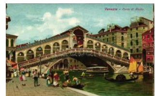
22607. ** Venice, Venezia; Ponte di Rialto / bridg 2000
