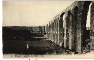
22754. ** Tunis, 'Aqueduc du Bardo' / Aquaduct o 1400
