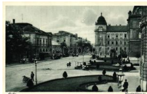
20558. * Győr, vasútállomás T1/2 1600
