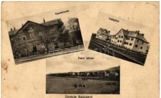
20131. ☒ Bánhida, vasútállomás, laképület, vasúti 3000
