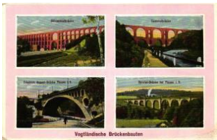
22364. ** Vogtland, Brück enbauten; Göltzschtalb 1600
