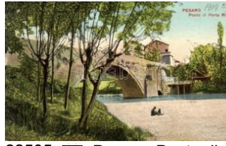
22505. ☒ Pesaro, Ponte di Porte Rimini / bridge (E) 1000
