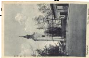
20797. ☒ Nagykálló, Katolikus templom; Vajda Ká 1600
