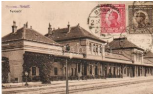
21671. ☒ Versec, Vrsac; va sútállomás / railway-sta 3000
