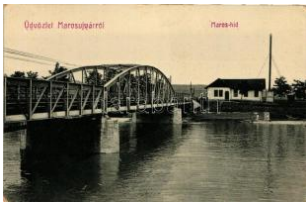
21211. ** Marosújvár, Maros-híd / bridge (EK) T2 1800
