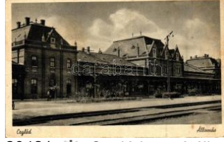
20421. * Cegléd, vasútállomás (fa) T4 1400
