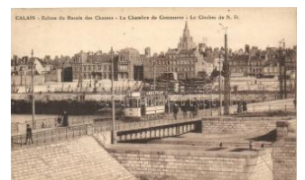
22135. ✳✳ Calais, Ecluse du Bassin des Chasses/ 1000
