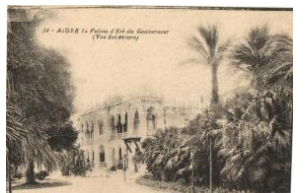
21708. * Algiers, Alger; 'Palais d'Été du Gouverno' 1000
