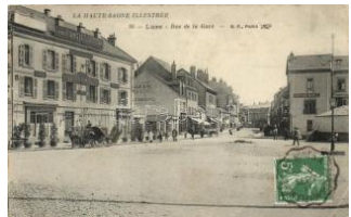
22154. ☒ Lure, Rue de la Gare, Hotel du Commerc 2000
