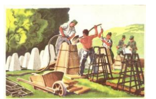
23407. ** Irgendwo in der Schweiz, Bau eines Hö 1400
