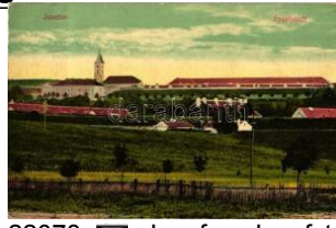
22078. ☒ Josefov, Josefsta dt; (wet damage) T3/4 1000
