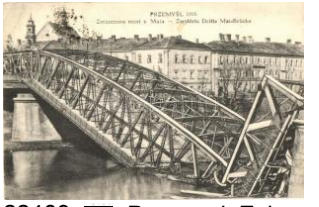
22489. ☒ Przemysl, Zniszczony most 3. Maja / Ze 3400
