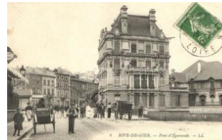
22340. ☒ Rive-de-Gier, Pont d'Egarande / bridge T1600
