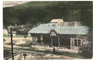
20308. * Budapest II. Hűvösvölgy, villamos végálló 2000
