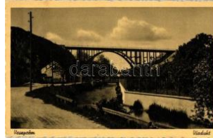
21335. ☒ Veszprém, viadukt T2 1000
