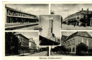
20567. ✳☒ Celldömölk, vasútállomás, Sághegyi Tr 1600
