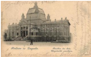
22001. ☒ Zagreb, Pavillon des Arts / art pavilion T 1200
