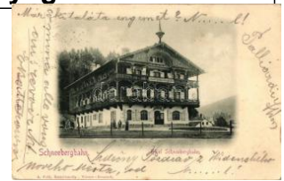
22160. ☒ 1898 Schneebergbahn, Hotel Schneeber 2400
