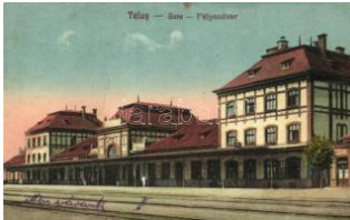
21625. ☒ Tövis, Teius; Vasútállomás / railway stat 1600
