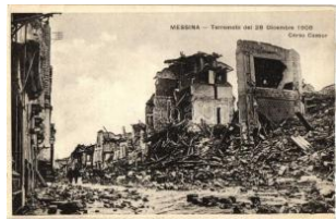
22732. ** 1908 Messina, Earthquake, Corso Cavo 2400
