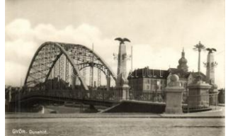
20726. ** Győr, Duna híd T2 1200
