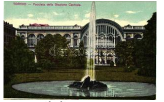
22844. ✱✱ Torino, Turin; Stazione Centrale / railw 1400
