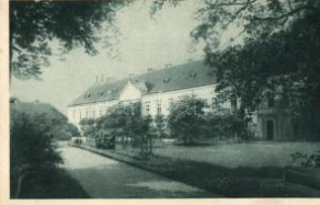
21774. ☒ Lednicróna, Lednické Rovne; Kastély, ka 3000
