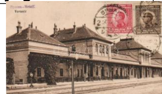
21496. Versec, Vrsac; vasútállomás / railway-sta 3000
