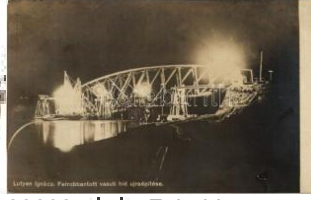
22602. ** Felrobbantott va sűti híd újraépítése, Ha 1000
