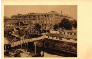
21946. ** Berlin, Siemensstadt, Kleinbauwerk / S 1200
