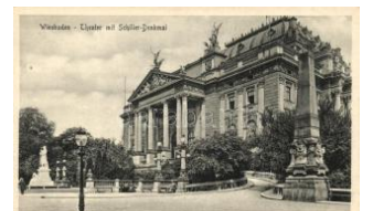
22032. ** Wiesbaden, Theater, Schiller-Denkmal 1400
