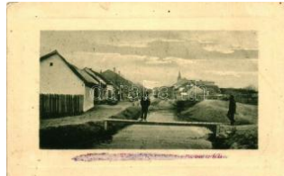
21475. ☒ Sid, utca, híd / street, bridge (EK) T2/3 3600
