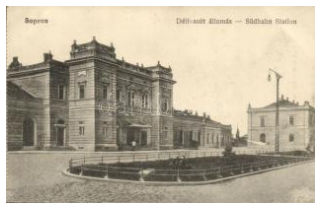
20842. * Sopron, Déli vasútállomás T2 2000
