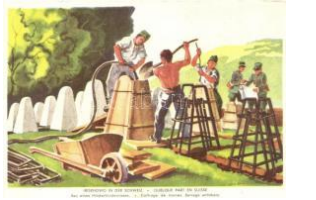
22657. ** Irgendwo in der Schweiz, Bau eines Hö 1400
