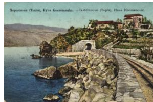
21903. ☒ Herceg Novi, Cas telnuovo; Haus Komne 1200
