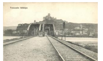
21384. ✱ Trenčsén, Trenčín; vasúti sín és híd, kiad 2800
