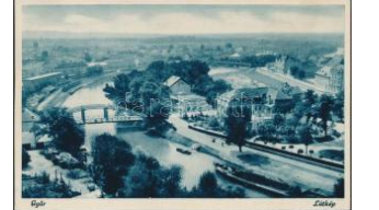
20544. ✳ Győr, híd (EB) T3 900
