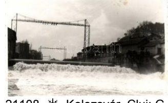
21108. ✳ Kolozsvár, Cluj; Gát a Szamoson / dam o 2000
