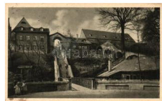
21932. Augsburg, Schwedenstiege / Swedish staircase 1000
