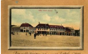
21053. ☒ Dég, Dej; Fő tér, Kereskedelmi Bank rés 3000
