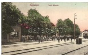
21027. Borosjenő, Ineu; vasútállomás / railway s 5000
