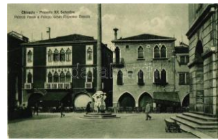
22056. ** Chioggia, Piazza XX Settembre, Pa 1600
