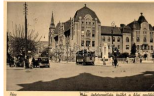
20796. ☒ Pécs, MÁV üzletvezetői épület, hősi e 2800
