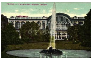
22589. ** Torino, Turin; S tazione Centrale / railw 1400
