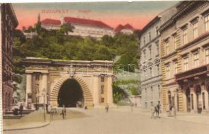
20258. ** Budapest I. Alagút, Takarékpénztár, T2 1400
