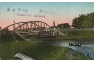
21729. ** Vinkovci, Vinkovce; sétány, híd / prom 1000
