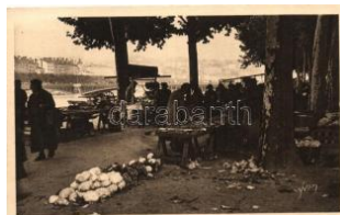
22058. * Lyon, Quai de la Guillotière / quay, market 1400
