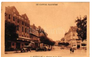
22013. * Aurillac, Avenue de la Gare, Grand Hotel 1600
