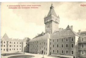
20620. Hajmáskér, Parancsnoksági épület udvar 2800
