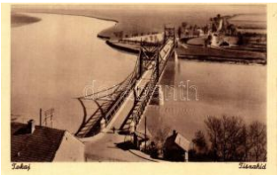
21066. * Tokaj, Tisza híd T 1/2 1000
