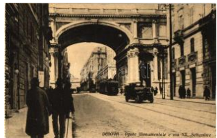
22466. ** Genova, Ponte Monumentale e via XX. 1400
