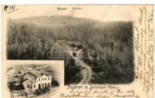
21694. ☒ Delnice; vasútállomás, vasúti alagút / rail 8000
