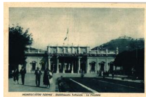
22507. * Montecatini Terme, 'Stabilimento Tettucc 1000
