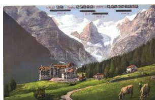
22590. ** Trafoi, Trafo Hotel T2 1200
