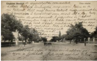
20166. ☒ Bana, utca rész let (ázott / wet damage) 2000
