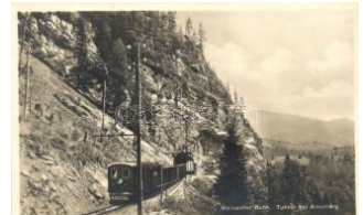
21876. ** Mariazeller Bahn, Tunnel bei Annaberg / 800
