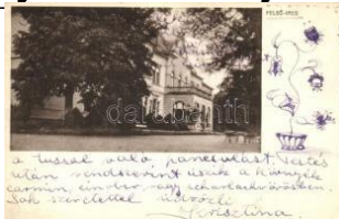
20552. ☒ Felső-Ireg, szálló épület Szénásy Béla ki 3800
