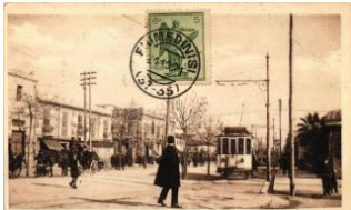
22831. * Messina, Viale S. Martino / street, tram T 1600
