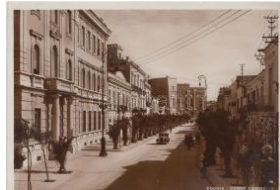
22812. ☒ Foggia, Corso Garibaldi T2 1200
