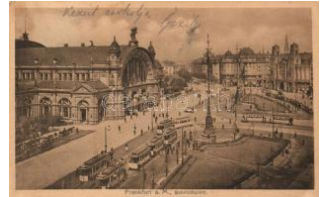
22718. ✉ Frankfurt am Main, Bahnhofplatz / railw 1400
