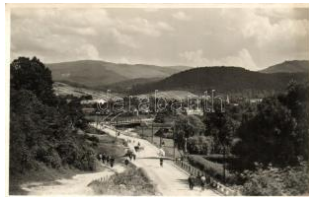
22125. Szolyva, bridge T2 1 000
