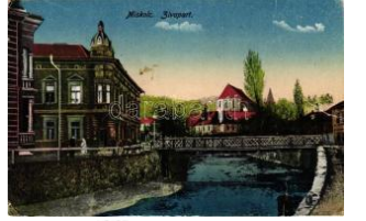
20994. ☒ Miskolc, Zivapark, híd (EK) T2/3 1600
