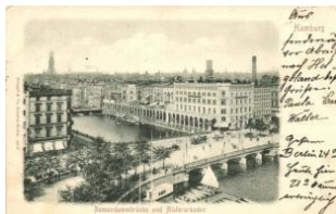
22729. ✉ Hamburg, Resendammbrücke und Alste 1400
