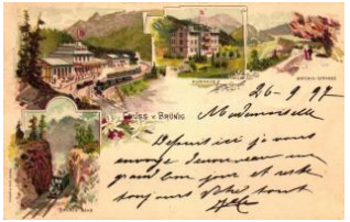
22947. ☒ 1897 Brünig, Bahnhof, Kuschhaus, Strasse 3400
