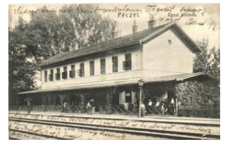
21082. ☒ Pécel, vasútállomás (kis szakadás / sma) 5500
