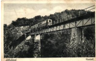
20931. ☒ Lillafüred, viadukt, vonat (fa) T3/4 1200
