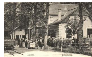
21614. Menyháza, Moneasa; vasútállomás / rail 5500
