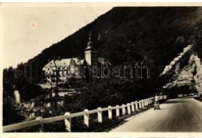
20937. ☒ Lillafüred, Palota szálló alagúttal T2 1200
