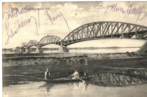
20158. ✳ Baja, Bátaszéki vasúti híd, kiadja Wurmfi 3600
