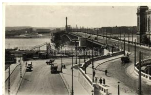
20327. ** Budapest, Horth y Miklós híd, Elevátor T3 800
