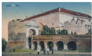
21160. ☒ Siklós, vár (kis szakadás / small tear) T3 1600
