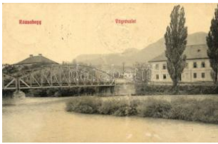
21999. ☒ Rózsáhegy, Vághíd / river, bridge T2/3 1600
