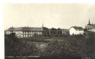
22324. ✳ Gleisdorf, Pensionat der Dominikanerin 1400
