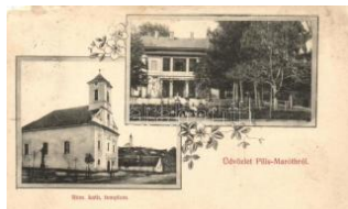
21127. ☒ Pilismarót, Római katolikus templom, ka 1000
