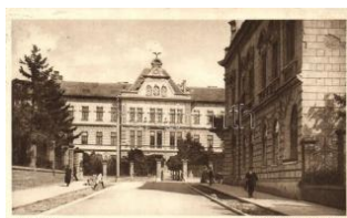
20873. ☒ Kaposvár, Állami reál-gimnázium (ázott s) 1000
