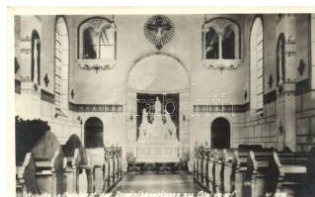
22325. ✳ Gleisdorf, Pensionat der Dominikanerin 1400
