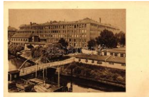
22689. ** Berlin, Siemensstadt, Kleinbauwerk / S 1200
