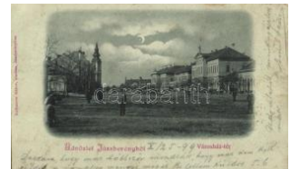
20482. ☒ 1899 Jászberény, Városház tér, Rothaus 3400
