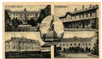
20458. ☒ Hajmáskér, E. 1. épület belső részlet, Va 1200
