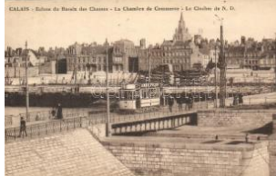
21681. ** Calais, Ecluse du Bassin des Chasses/ 1000
