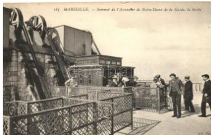
21725. ** Marseille, Sommet de l'Ascenseur de No 2400
