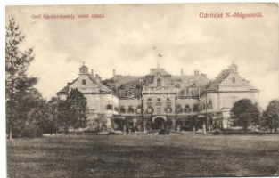
20636. ☒ Nagymágocs; Gróf Károlyi-kastély keleti 4000
