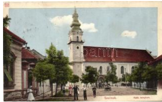
20852. Szolnok, Katolikus templom (kis szakadá) 2400
