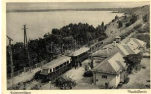
20126. Balatonvilágos, V asútállomás T2 2400
