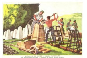
22541. ** Irgendwo in der Schweiz, Bau eines Hö 1400
