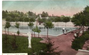
20798. * Sopron, Lövér uszoda (Rb) T2/3 800
