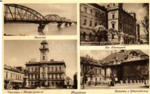
21204. ☒ Komárom, Komárom; Dunai híd, Királyi T 1000
