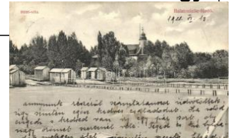
20117. Balatonlelle-fürdő, Hütti-villa, Balaton par 1200
