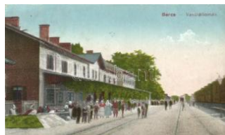
20135. Barcs, vasútállomás (kis szakadás / sma 3000
