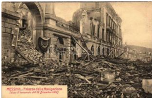
22373. ** 1908 Messina, dopo il terremoto, Palaz 2200
