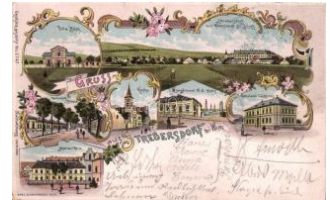
21676. Strebersdorf bei W ien; Villa Böck, Pansion 4000
