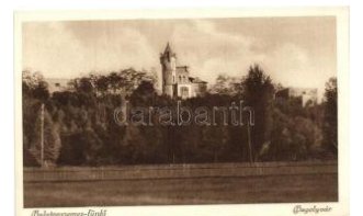
20148. ** Balatonszemes-fürdő, Bagolyvár T1/2 1200
