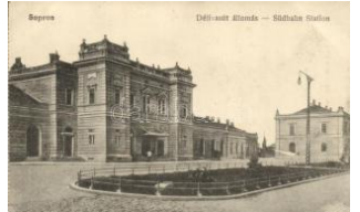
20744. * Sopron, Déli vasútállomás T2 2000
