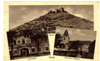
21372. ☒ Torna, Turna nad Bodvou; várom, közsé 3000
