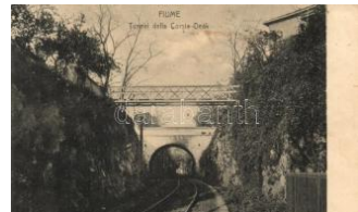
21456. ✳✳ Fiume, Tunnel della Corsia Deak / 'Dea 3600
