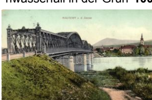
21661. ☒ Mautern an der Donau, bridge (EK) T2/3 1800
