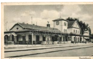
20117. Balatonalmádi, va sútállomás (EK) T2/3 1200
