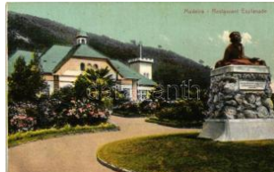
22542. * Madeira, Restaur. ant Esplanade T2 1400
