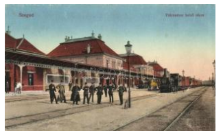
20764. ** Szeged, vasútállomás belső része, vág 2800
