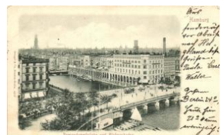
22240. Hamburg, Resendambrücke und Alste 1400
