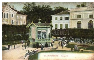
21626. * Bad Gleichenberg, Kurpark / spa park (b) 1200
