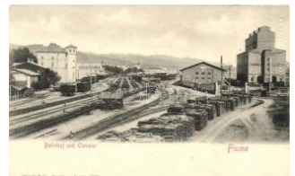
21448. ✳ Fiume, vasútállomás, Gabona elevátor / r 3800
