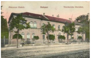
20297. ☒ Budapest VII. Állatorvosi főiskola, főépüle 2800
