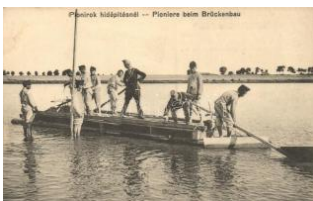
23182. Pionirok hídépítésnél; A bánat és a nyó 1800
