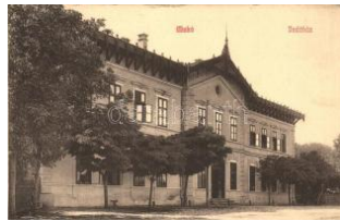
20578. * Makó, Indóház, vasútállomás T1/2 4000
