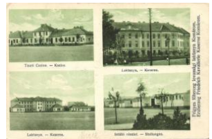
21284. ** Komárom, Komárom; Frigyes főherceg 6000
