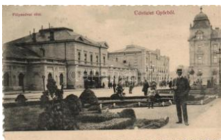
20465. ☒ Győr, Vasútállomás (ázott / wét damage) 1600
