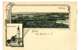
21240. ✉ 1898 Lajtabruck, Bruck and der Leitha; T 3200
