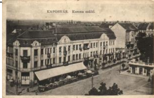
20414. ✳ Kaposvár, Korona Szálló, a Rázsó Testvé 1800
