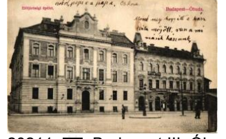
20211. Budapest III. Óbuda, Előjárósági épület, 6000
