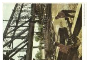
22493. ** Deutsche Brückenbau Pioniere / WWI 1000
