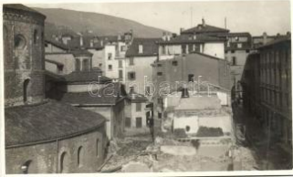
21665. ** Brescia, Via Trieste; construction site T 1000
