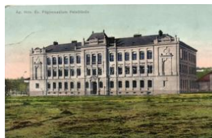
21239. ✉ Felsőlövő, Oberschützen; Evangélikus F 1400
