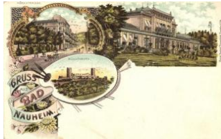
21579. * Bad Nauheim, Mühlentempel, Parkstrasse, 2600
