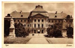
20338. ☒ Eger, líceum (ázott / wet damage) T4 800
