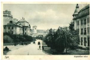
20337. ✳ Eger, Káptalan utca (Rb) T3/4 1000
