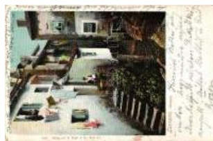
21199. * Lovran, Lovrana; Strasse / street (EK) T2 1400
