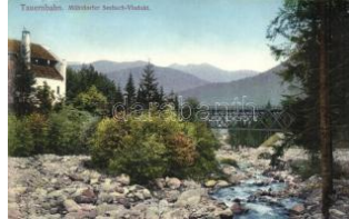
21286. ** Mühlendorf, Taernbahn, Seebach-Viadukt 1000
