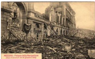
21697. ** 1908 Messina, dopo il terremoto, Palaz 2200
