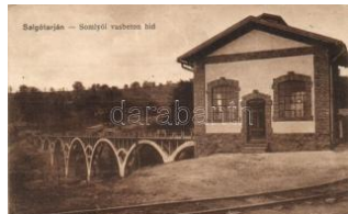
20556. ☒ Salgótarján, Somlyó vasbeton híd, viadom 1600
