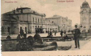
20379. Győr, Vasútállomás (ázott / wet damage) 1600
