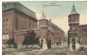
21326. Liège, Caserne des Lanciers / barracks T2200
