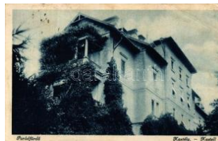
20515. ☒ Parádgyógyfürdő, kastély (ázott / wet damage) T 800
