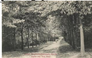
21950. ☒ Heinitz, Königliche Steinkohlenbergwerk 2400
