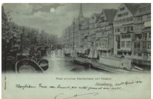
21937. ☒ Hamburg, Fleet zwischen Deichstrasse und M 1400
