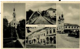
20990. Székelyudvarhely, Küküllő híd, Városház 1200
