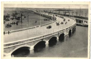
22337. ** Venice, Venezia; Ponte Littorio / bridge, 1200
