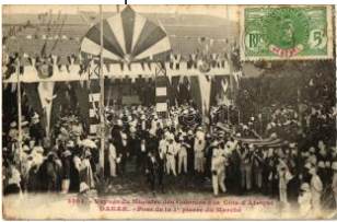
22461. ☒ Dakar, Pose de la premiere pierre du M1800
