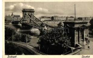
20174. * Budapest, Lánc híd, budai hídfő (EK) T2/3 1000
