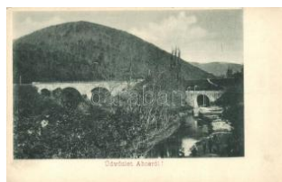
21042. ** Abos, híd / bridge T2 1800
