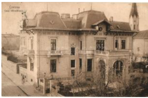
22389. [ ] Craiova, Casa Va Ilmurescu / villa T2 2400
