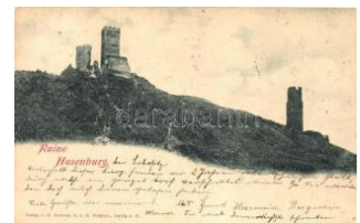
21556. ** Hazmbruk, Hase nburg; Hrad Hazmbruk 2000
