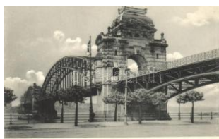
21914. *** Düsseldorf, Rheinbrücke / Rhine bridge 1400
