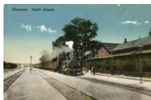
21175. * Komárom, Komárno; Vasútállomás, gőzm 3000
