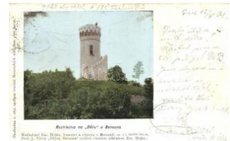
21548. ** Beroun, Rozhled na na Dedu / tower T2/ 1400
