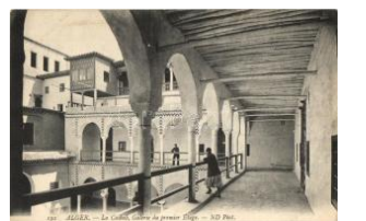
21404. ** Algiers, Alger; La Casbah, Galerie du p 1400
