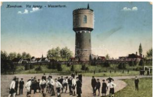
21185. ✱✱ Komárom, Komárom; Víztorny / water tower 800
