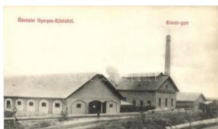
20569. * Nyergesújfalu, Ete rnitgyár T1/2 4200
