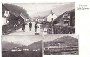
20845. ** Csíkygyimes, va sútállomás, utca / railw 5500
