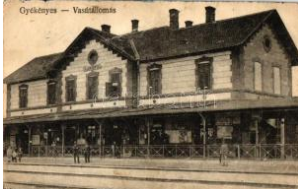
20404. * Gyékényes, vasútállomás (fl) T3/4 1000
