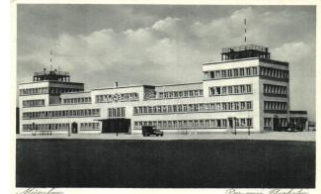
21992. ☒ München, Der neue Flughafen / The new 1600
