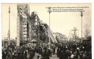
21529. ** 1910 Brussels, Bruxelles; Incendie dan 3000
