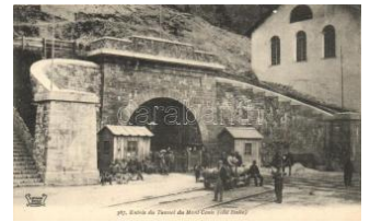
21664. * Mont Cenis, Entrée du Tunnel chemin de 1600
