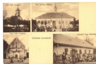
20507. Levelek, Görög katolikus templom és i 6000
