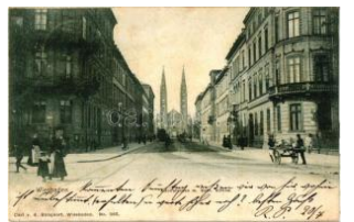
22040. Wiesbaden, Adolfrasse mit der Katolis 1400
