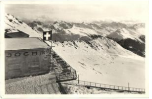
22433. ☒ Davos-Parsonnbahn, Station Weissfluhj 1400
