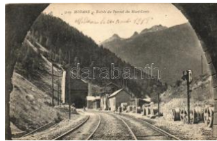
21663. * Modane, Entrée du Tunnel du Mont-Ceni 1600
