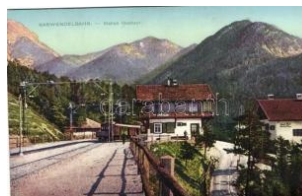
21557. * Hochzirl, Karwendelbahn Station / cable c 2000
