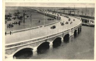
22313. ** Venice, Venezia; Ponte Littorio / bridge, 1200
