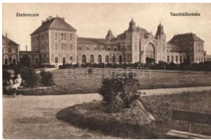
20347. ☒ Debrecen, Vasútállomás T2/3 1800
