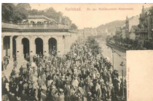
21655. ✉ Karlovy Vary, Karlsbad; An der Mühlbrunnen-Kolo 1400
