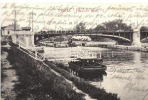
21677. ☒ Praha, Prag; Hlávkuv most / bridge T2 1400
