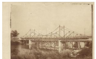
20916. * Fenyőfalva-Felek , Bradu-Avrig; híd / Brid 3200
