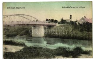
20944. * Kisjenő, Chisineu -Cris; Fehér-körös híd é 1200
