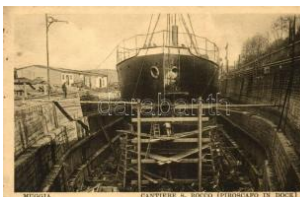
22159. ☒ Muggia, Cantiere S. Rocco, Piroscifo in 4800
