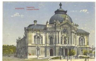
20309. ☒ Budapest XIII. Vígyszínház (kis szakadás / 800
