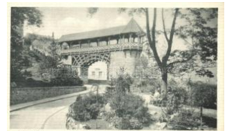
22050. Wiesbaden, Heid enmauer, römisch. Tor 1200
