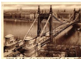
20177. Budapest, Erzsébet et híd, budai hídfő, villa 1200
