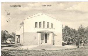
21003. ☒ Nagybánya, Felső iskola; Kovács Endre 5500
