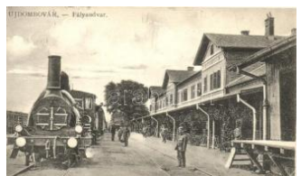
20366. ☒ Dombóvár, Újdombóvár; vasútállomás, gő 4000
