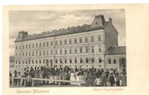
20561. ** Makó, Állami fő gimnázium (vágott / cut) 3000
