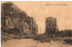
22139. ** 1908 Messina, d opo il terremoto, Via Pr 2000
