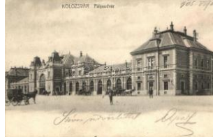
20969. ☒ Kolozsvár, Cluj; v asútállomás / railway st 1400
