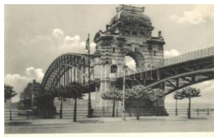
21940. ** Düsseldorf, Rheinbrücke / Rhine bridge 1400
