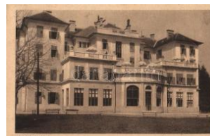
20114. ☒ Balatonföldvár, Kupavezer szálló T2 1000
