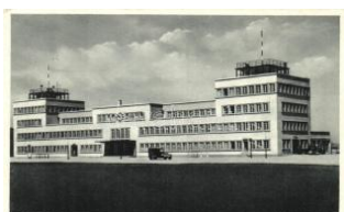
22008. ☒ München, Der neue Flughafen / The new 1600
