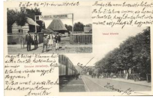
21141. ☒ Zsibó, Vasútállomás, Sajovic és Komo 12000
