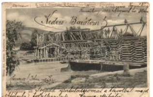
21511. * Korneuburg, 'Brückenbau' K.u.k. Eisenbahn 1400
