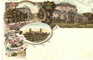
21732. Bad Nauheim, Mühlentempel, Parkstrasse, 2600
