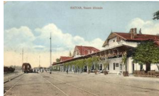
20520. Hatvan, vasútállomás (fl) T2/3 2800
