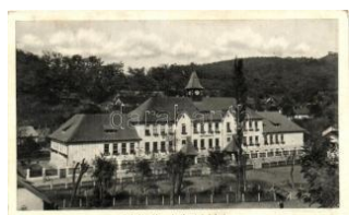
20716. * Salgótarján, Acélg yári iskola T2/3 2000
