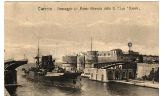
22261. * Taranto, Passaggio dal Ponte Girevole 3000
