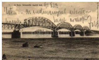
20116. Baja-Bátaszéki vasúti híd; ifj Wagner An 4800
