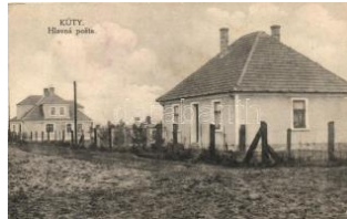
21193. ☒ Jókút, Kúty; Posta / Post Office (EB) T3 6000
