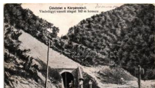
21148. ** Visó-völgy, Vasúti alagút / railway tunn 1000
