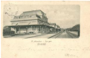
20488. ☒ 1899 Gödöllő, vasútállomás T2 1400
