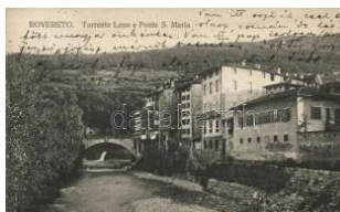
21897. ☒ Rovereto, Torren te Leno e Ponte S. Mar 1000
