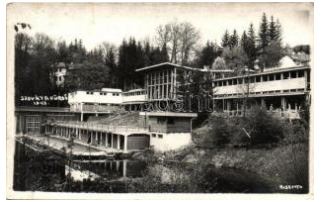
21124. ✱ 1941 Szováta-fürdő, Sovata; épülő szállod 2000
