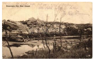
22384. ☒ Brest-Litovsk, Gesprengtes Fort / blown 1600
