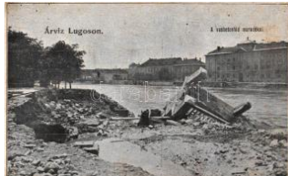
20997. ** Lugos, Árvíz; a vasbetonhid martaléka 4000
