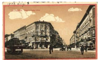
20308. Budapest VI. Teréz körút, Podmanitzky 2000
