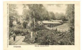
20934. ** Előpatak, Valcele; Károly uszoda-fürdő 3800
