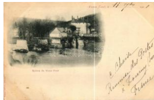
21685. ☒ Vernon (Eure); Ruines du Vieux Pont / R 2200
