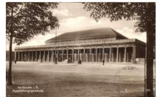
21815. ☒ Karlsruhe, Ausstellungsgebäude / exhibition building 1000
