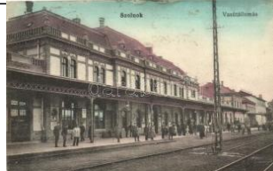
20758. ☒ Szolnok, vasútállomás T2 2000
