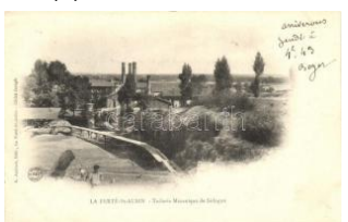
21649. ** La Ferté-St.-Au bin, Tuilere Mécanique 4000
