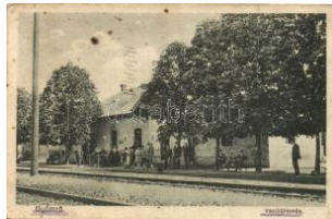
20409. * Gyömrő, vasútállomás (EK) T2/3 4000
