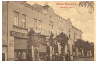
21325. ✱ Tiszaújlyuk, Vylok; Gazdasági bank, Wein 5500
