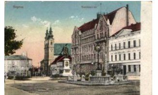
20687. ☒ Sopron, Széchenyi tér, templom (ázott) / 1200
