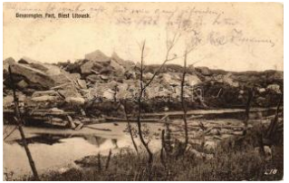
22461. Brest-Litovsk, Gesprengtes Fort / blown 1600
