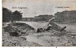
20986. ✳✳ Lugos, Árvíz; a vasbetonhid martaléka 4000
