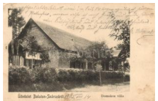
20104. ✱ Balatonszárszó, Dömökös villa (EK) T2/3 1600
