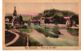
21774. * Bad Kreuznach, Partie an der Nahe / view 1400
