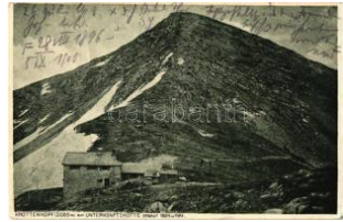
21822. ☒ Krottenkopf, Unterkünftshütte / rest house 1600
