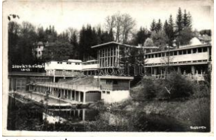
21120. * 1941 Szováta-fürdő, Sovata; épülő szállod 2000
