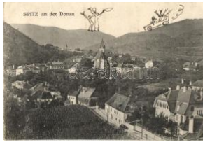
21379. ☒ Spitz an der Donau (wet damage) T4 1000
