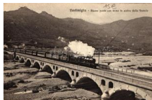
21852. * Ventimiglia, Nuov o ponte con treno in arr 3000
