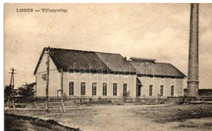
20854. ** Lugos, Lugoj; Villanytelep / power stati / 6000
