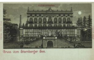
21686. ✨ Starnberger See, Rottmanshöhe Hotel, O 2200
