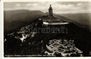
21664. ✨ ✨ Kyffhäuser Mon ument, Ausgegrabener 1400
