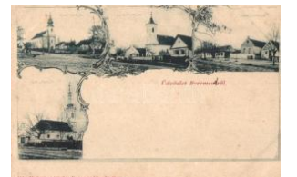
20143. Beremend, Zsinagóga, római katolikus, 3000
