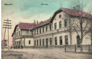
20134. Bánréve, Vasútállomás T2 2000
