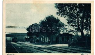
20323. ☒ Csömör, vasútállomás T2 5000
