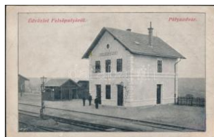
21295. * Felsőpulya, Oberpullendorf; vasútállomás 18000
