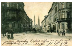
21691. ☒ Wiesbaden, Adol fstrasse mit der Katolis 1400
