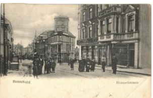
21682. ✨ ✨ Remscheid, Bis markstrasse / street , 1400
