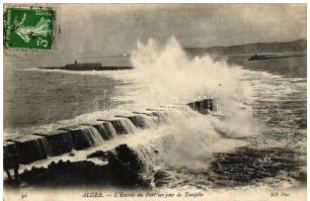
21313. ☒ Algiers, Alger; L'Entrée du Port un jour de 1200
