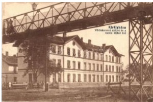
21181. ✳ Királyháza, Koroleve; Vöröskereszt épülete 1800
