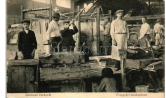
20567. ☒ Parád, Üvegyár i munkajelenet, belső, 11000
