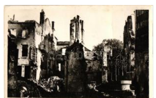
21501. ** Hennebont, Sinistré, Puits Ferré / disas 2000
