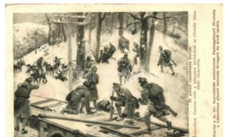
22384. ☒ 29. számú csataképes kártya, Katonáink 2000
