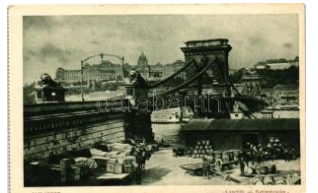
20174. ** Budapest, Lánc híd, rakpart T2 1200
