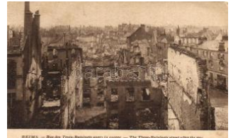
22217. ** Reims, Rue des Trois-Raisinets après I 1200
