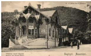
20343. ** Budapest XII. Zugliget, villamos vasúti 8000
