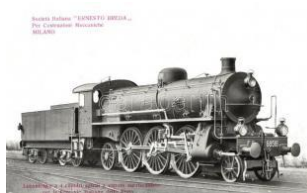
22634. ✨✨ Locomotiva a 4 cilindri eguali a vapore 3000
