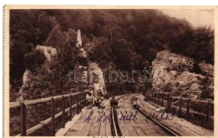
20413. ☒ Cuha-völgyi vas úti híd T2 2000
