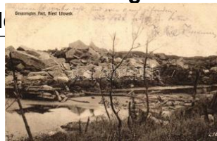
22239. ☒ Brest-Litovsk, Sprengtes Fort / blown 1600
