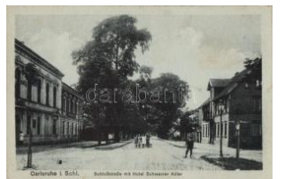
21778. *** Pokój, Carlsruhe, Schlossstrasse, Hot 3000
