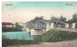
20567. ✱ Körmend, Rába híd (Rb) T2/3 1400
