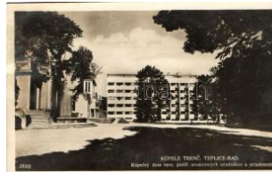
21291. * Trencséntepec-fü rdő, Trencianske Teplice 1000
