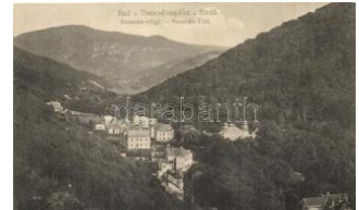
21292. ☒ Trencséntepec-fü rdő, Trencianske Teplice 800
