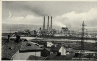
21603. ✳✳ Ervenice, Sees tadtI; Kraftwerk / power 2000
