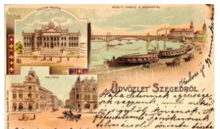
20754. ☒ 1899 Szeged, Közüti híd, rakpartal, 4000
