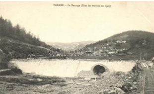
21695. ** Tarare, Le Barrage / dyke T1 2800
