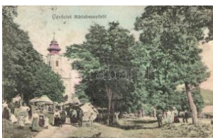
20599. ☒ Máriabesnyő, templom (ázott / wet damage) 800
