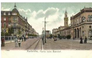
21883. ** Karlsruhe, Partie beim Bahnhof / by the 2400
