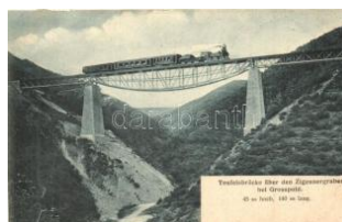
21049. ☒ Nagypold, Gros spold; Ördög-vasúti híd 5000
