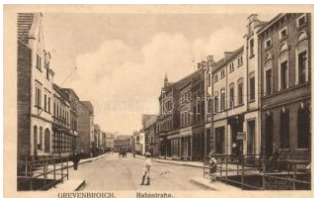
21871. * Grevenbroich, Bahnstrasse / street T2 2600
