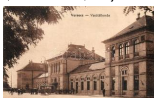
21440. ☒ Versec, Vrsac; vasútállomás / railway sta 3000
