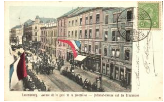
21802. ☒ Luxembourg, Ave nue de la gare et la pro 6000
