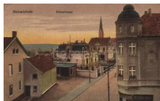
21878. * Holzwickede, Alleestrasse / street T2 2000
