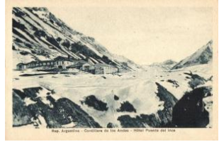
21490. ** Andes, Hotel Puente del Inca T1 1400
