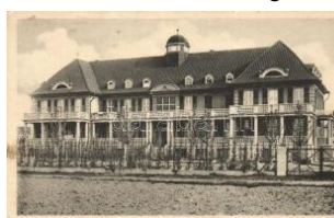
21888. * Kehl am Rhein, Krankenhaus / hospital T2600
