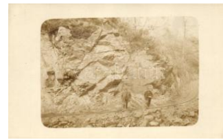
21110. ✱✱ Szinice, Svinita ; Vasút / railway, photo 2000
