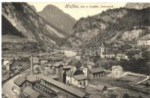
21507. ** Hiefiau, Fabrik / factory T1 2400
