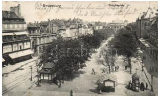
21692. ☒ Strassbourg, Broglieplatz, drogerie / squ 1400
