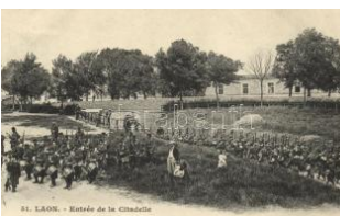
21663. ☒ Laon, Entrée de l a Citadelle / citadel T2 2000
