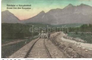
21325. ☒ Kárpátok, vasúti sín, hajtány / railway, h 1400
