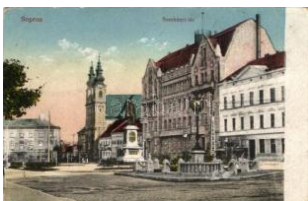
20755. ☒ Sopron, Széchenyi tér, templom (ázott) / 1200
