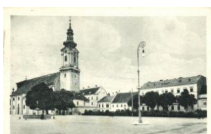
21575. ☒ Lajtabruck, Bruck an der Leitha; Hauptp 2000
