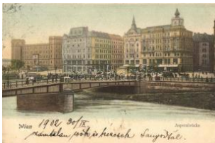
21641. * Vienna, Wien; Aspernbrücke / bridge (EK 1000
