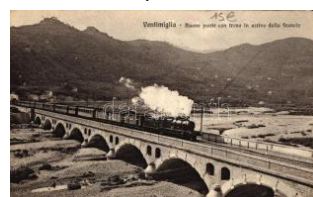
22120. * Ventimiglia, Nuov o ponte con treno in arr 3000
