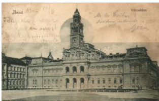
20877. * Arad, Városháza / town hall (EB) T3 900
