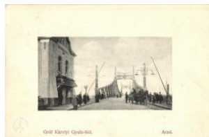
20874. * Arad, Gróf Károlyi Gyula híd / bridge T2 4000
