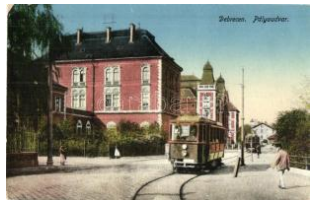
20418. ✱✱ Debrecen, Vasútállomás, villamos (EK) 4400
