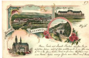
21174. * Kassa, Kosice; Tehányi vasúti alagút, fels 5000
