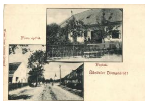
20443. ✱✱ Dömsöd, Posta épület, paplak, kiadja W 5500
