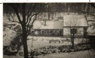
20588. ✨✨ 1937 Kóspallag, Menedékház, photo (E) 2000
