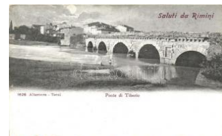
22084. ** Rimini, Ponte di Tiberio / bridge (EK) T 1400
