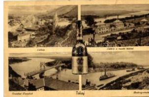
20819. ** Tokaj, Vasúti híd, Erzsébet Tisza híd, T 1000
