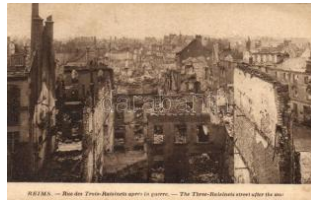
22623. ** Reims, Rue des Trois-Raisinetts après l 1200
