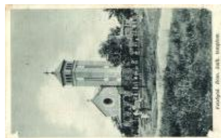
20479. ☒ Felsőgöd, Római katolikus templom (EB) 1400
