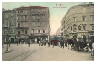
21479. ☒ Fiume, Adamich tér, villamos, bank, F. A 3200
