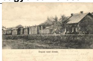
20650. ☒ Öreglak, vasútállomás, gőzmozdony (E 16000)
