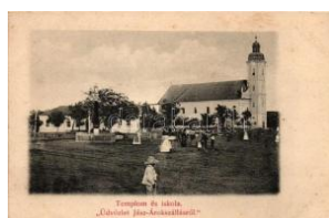
20543. ** Jászárokszállás, templom, iskola (vágó 2800
