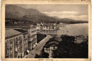
22037. Formia, Panoramia, Casa del Fascio(?) / 2000
