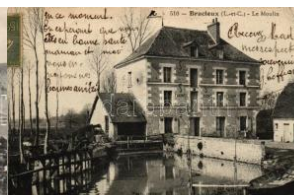
21755. ☒ Bracieux, Le Moulin Farines Sons Recou 1000
