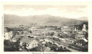
21389. ** Zsarnóca, Zarn ovica; látkép épülő ház 9000
