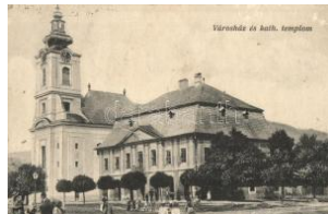
21130. ☒ Breznóbánya, Brezno; Városház, Katolikus 1600
