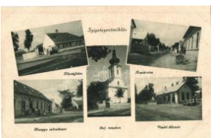
20737. Szigetszentmiklós, Községháza, vasútállomás 1000
