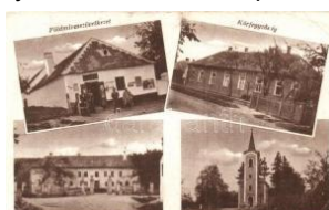
20803. ** Torony, Földmívesszővetkezet, Körjeg 1000
