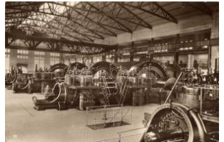
20590. ** Ózd, Rimamurány-Salgótarjáni vasmű, 1200
