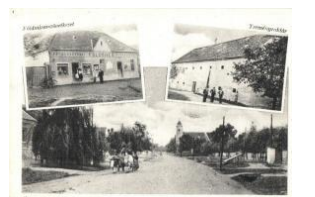
20707. Sopronkövesd, F őldmíves szövetkezet, 1200
