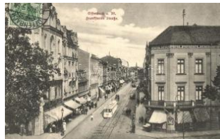
21875. ☒ Offenbach, Frankfurter Strasse (EK) T2/3 2600
