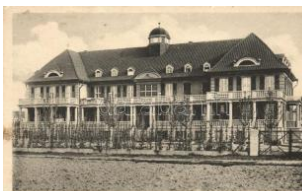
21853. * Kehl am Rhein, Krankenhaus / hospital T2600
