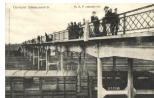
20104. ** Békéscsaba, M AV vasbeton híd, vonat 8500
