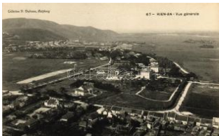
22022. ** Kien-An, Vue Generale / view T1 1600
