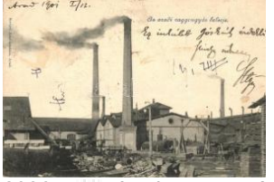
20865. ☒ Arad, vagongyár, belső / factory (EK) T2 7000
