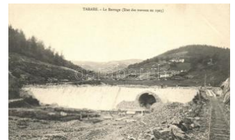
21676. ** Tarare, Le Barrage / dyke T1 2800
