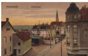
21846. * Holzwickede, Alleestrasse / street T2 2000
