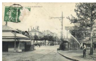
21667. * Paris, La Porte de Saint-Cloud / gate, wa 2000
