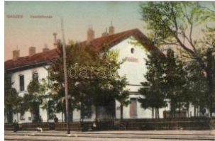
20458. ** Isaszeg, Vasútállomás ( apró felületi sé 1000
