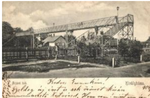
21346. * Királyháza, Koroleve; Vasúti átjáró híd, ki 3000
