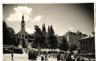
20724. 1908 Székelyudvarhely , Rómái katolikus temp 1200
