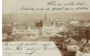
20620. ☒ 1899 Déva, Megye háza, építkezés / coun 3000
