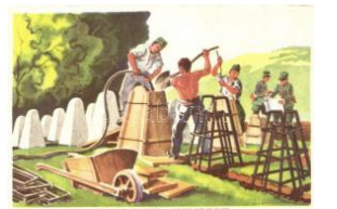
21842. ✱✱ Irgendwo in der Schweiz, Bau eines Hö 1400
