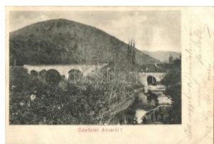
20759. 1 Abos, Obisovice; Híd / bridge (ázott saro) 3000
