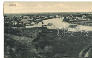
20989. ☒ Sziszek, Sisak; Vasúti híd, panorámalap 8000
