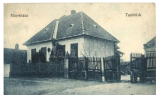
20403. ☒ Majosháza, Tanítóház (EK) T2/3 2000
