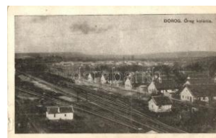
20313. ✱ Dörög, Öreg kolónia, vasút (kis szakadás) 3200
