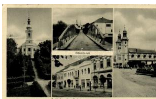
20728. 1908 Székelyudvarhely , Küküllő híd, Városház 1200
