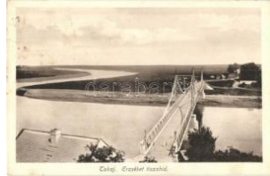
20809. ☒ Tokaj, Erzsébet Tisza híd T1/2 1000
