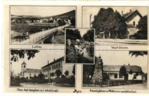
20075. ☒ Apc, vasútállomás, Római katolikus temp 1600
