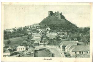
20699. * Somoskő, vár (ázott / wet damage) T3 1000
