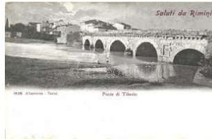
22122. ** Rimini, Ponte d i Tiberio / bridge (EK) T 1400
