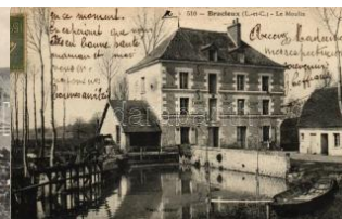
21759. ☒ Bracieux, Le Moulin Farines Sons Recou 1000
