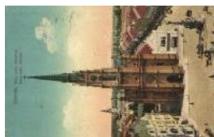
21558. ☒ Újvidék, Novi Sad; Római katolikus temp 1200
