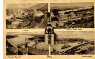
20810. ✳✳ Tokaj, Vasúti híd, Erzsébet Tisza híd, T 1000
