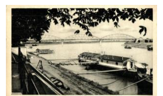
21567. ☒ Zenta, Senta; Vólt Tisza híd / bridge T2 1000
