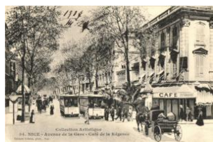
21789. ** Nice, Avenue de la Gare, Cafe de la R 3000
