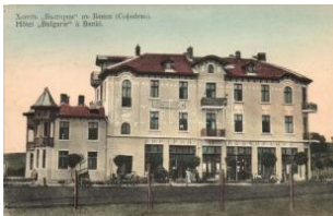
21688. * Banki, Hotel Bulg arie 'Hughesstation der 2400
