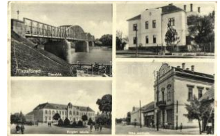
20806. ☒ Tiszafüred, Tisza híd, Polgári iskola, Fős 1000
