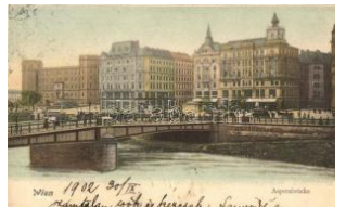
21645. * Vienna, Wien; Aspernbrücke / bridge (EK) 1000
