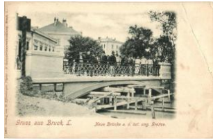
21577. * Lajtabruck, Bruck an der Leitha; Új híd a 4000
