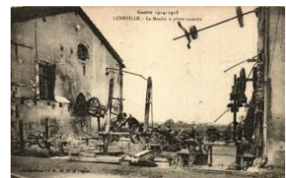
21779. * Lunéville, Moulin a platre incendie / destr 2000
