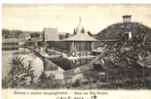
21167. ☒ Vízakna-Sósógyógyfürdő, Ocna Sibiului; fű 1000
