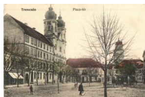
21402. ** Trencsén, Trencin; Piac tér, kiadja Ste 2000
