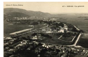
22119. Kien-An, Vue Generale / view T1 1600
