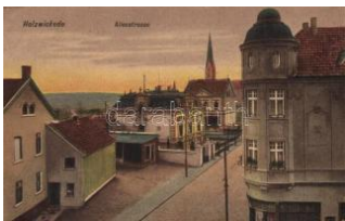
21864. ✳ Holzwickede, Alleestrasse / street T2 2000
