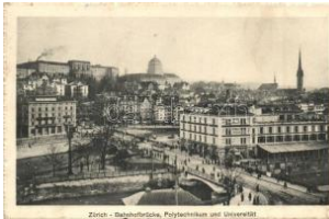
22073. M Zürich, Bahnhofrücke, Polytechnikum u 1200
