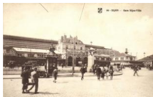
21685. * Dijon, Gare Dijon Ville / railway station, a 1600
