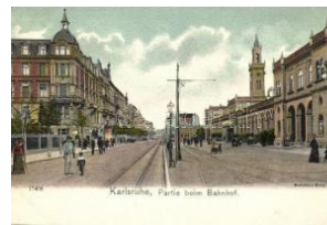
21867. ✳✳ Karlsruhe, Partie beim Bahnhof / by the 2400
