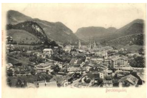
21824. ☒ Berchtesgaden, Embankment T2 3000
