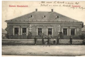
21157. ☒ Abaújszina, Senta; Postaépület / post office 6000
