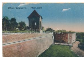
20682. Szigetvár, várfal (kis szakadás / small te 1000
