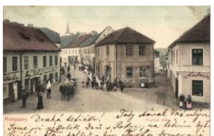
21641. ☒ Rokycany, Prazska ulice / street, shops 1400
