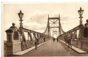
20724. ✱✱ Tokaj, Erzsébet Tisza híd T1/2 800
