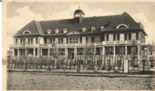
21869. * Kehl am Rhein, Krankenhaus / hospital T2600
