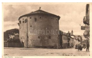
21569. ** Salzburg, Hexenturm / Witch Tower (E) / 2000
