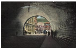
22005. ☒ Trieste, Tunnel di Montuza dall' interno 1400
