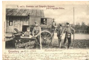
22354. * Korneuburg, K.u. K. Eisenbahn- und Tele 6000
