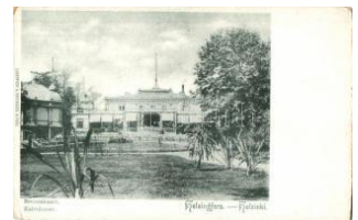
21830. ** Helsinki, Helsingfors; Brunnschuset, Ka 1400
