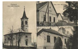
20594. ☒ Felcsút, római ka tolikus templom, iskola, 4000
