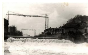
21121. * Kolozsvár, Cluj; Gát, vízimalom / dam, wa 3000
