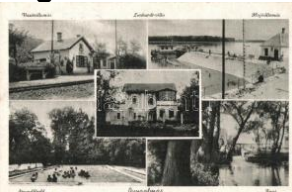
20556. ☒ Dunaalmás, vasú állomás, Lenhardt-villa 1000
