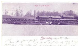
20205. Barcstelep, Hajós- és Vasútállomás, Mau 3000
