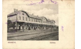
20202. Bánréve, vasútállomás T2/3 1800
