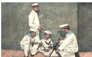
22176. ** Pola, Schieman nsarbeiten / K.u.K. Krie 2000
