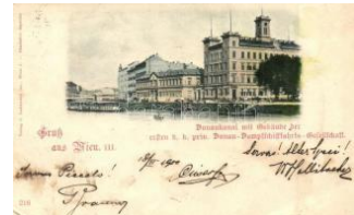
21762. * Vienna, Wien III. D. onaukanal mit Gebäude 1600
