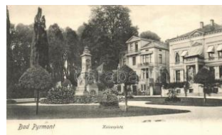
21886. ** Bad Pyrmont, Kaiserplatz / castle (cut) 1000
