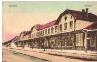
20204. Bánréve, vasútállomás T2 1600
