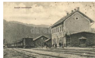
21505. ☒ Parajd, Praid; vasútállomás, vagonok, R 11000
