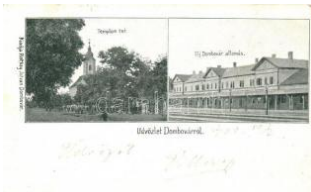
20684. * Dombóvár, Újdombóvár; vasútállomás, Te1400
