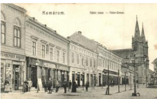
21696. ☒ Komárom, Komárom; Nádor utca, Rehbe 3400
