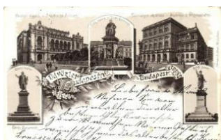
20286. ☒ 1899 Budapest, Fővárosi Vigadó, Deák, P1600
