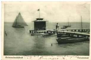
20181. ☒ Balatonalmádi-fü rdő, Csónakkikötő, vitorlás 800
