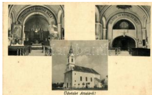
20150. ✉ Attala, Római katolikus templom, belső, 1000
