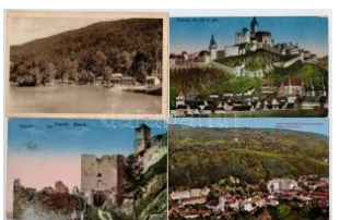
21864. ✳✳✳ Trencsén, Trencin; 12 db főleg régi 3000
