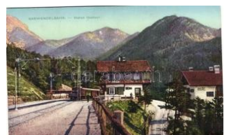
22115. Hochzirl, Karwendelbahn Station / cable ca 800
