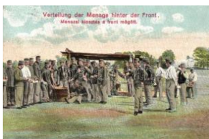
22658. ☒ Verteilung der Menage hinter der Front / 2000
