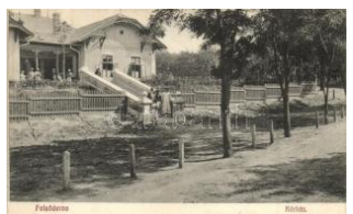
21312. * Felsőderna, Derna; Kórház / hospital T2 2800
