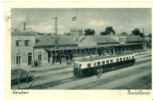
21717. ✳ Komárom, Komárom; Vasútállomás, vona 2000
