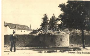
20732. ☒ Sopron, Régi bástya, pipázó úr, Zsaboko 5500
