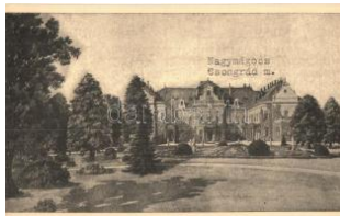
20642. ✱ Nagymágocs, Gróf Károlyi kastély, hátold 1600
