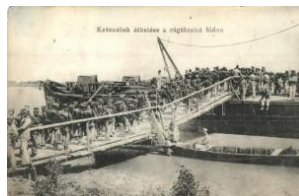
21965. * K.u.K. katonák átk elése a rögtönzött híd 2000
