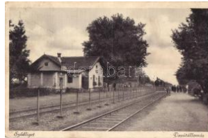
20788. ✱ Szödliget, vasútállomás, vasútállomás épülete 3000
