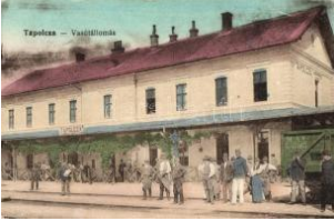
20794. ☒ Tapolca, Vasútállomás, MAV vagon (EK) 2000
