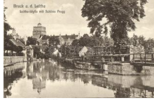
21500. ☒ Lajtabruck, Bruck an der Leitha; Leitha-Id 1600
