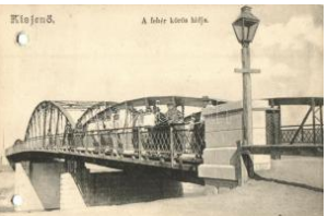
20960. ☒ Kisjenő, Chisineu-Cris; Fehér-Körös híd 1000
