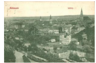
20981. ☒ Kolozsvár, Cluj; I átkép, vízvezeték csato 1200
