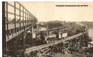
21668. * Narew, Provisorische Eisenbahnbrücke / 4000
