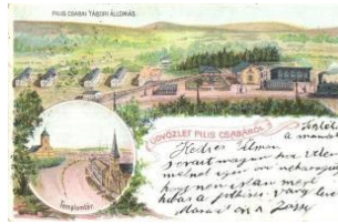
20676. ☒ Piliscsaba, Tábori állomás, vasútállomás 3200
