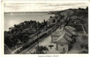
20183. * Balatonvilágos-fürdő, vasútállomás, vitor 1800
