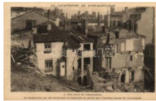
21621. ** Lyon-Saint-Jean, l'effondrement / landsl 3000
