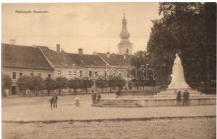
21339. ☒ Rozsnyó, Rožňava; Rákóczy tér, Fekete 3000
