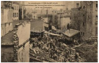
21623. ** Lyon-Saint-Jean, l'effondrement / landsl 3000
