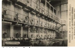
21637. ** Paris, Batterie de 51 Cuves en Cinq Eta 5000
